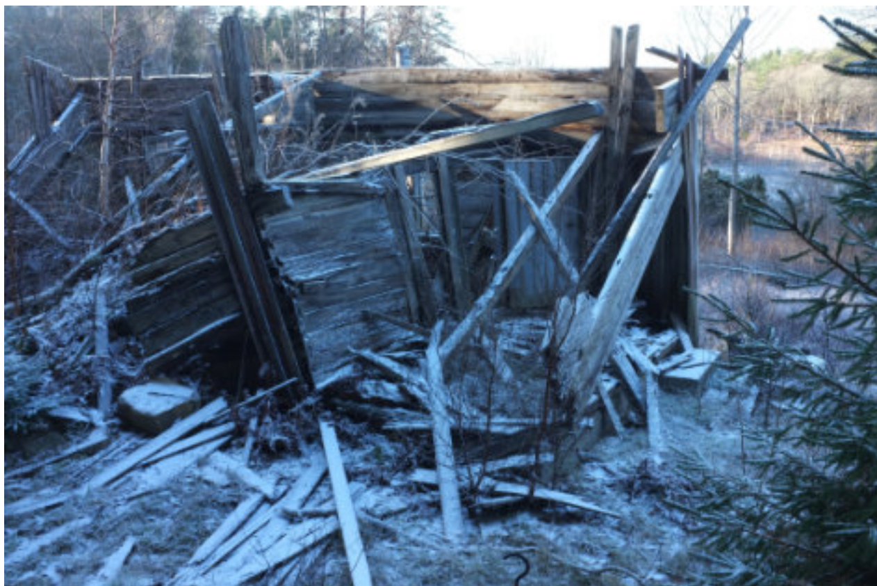
Illustration 33. KUL 28, lägenhetsbebyggelse, L2025:8387. På bilden syns den tillbyggda verandan. Denna har uppförts i plankteknink till skilnad från den övriga stuga vilken är timread. Den är således ett senare tillskott till huset. Foto mot sydväst.
