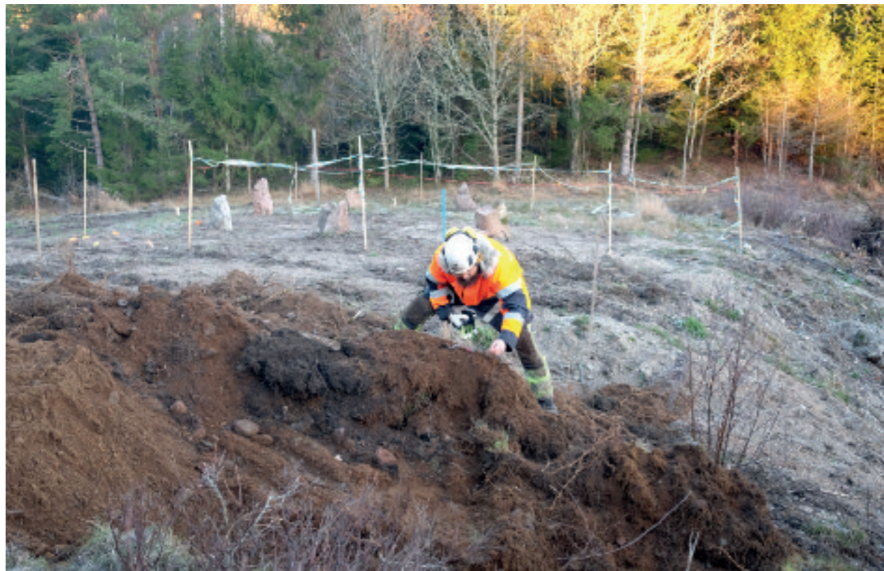
Illustration 2:8. Inledande avbanning av schakt 1. Oloffinrensar schaktmassor. I bakgrunden den restaurerade domarringen. Foto mot norr.
