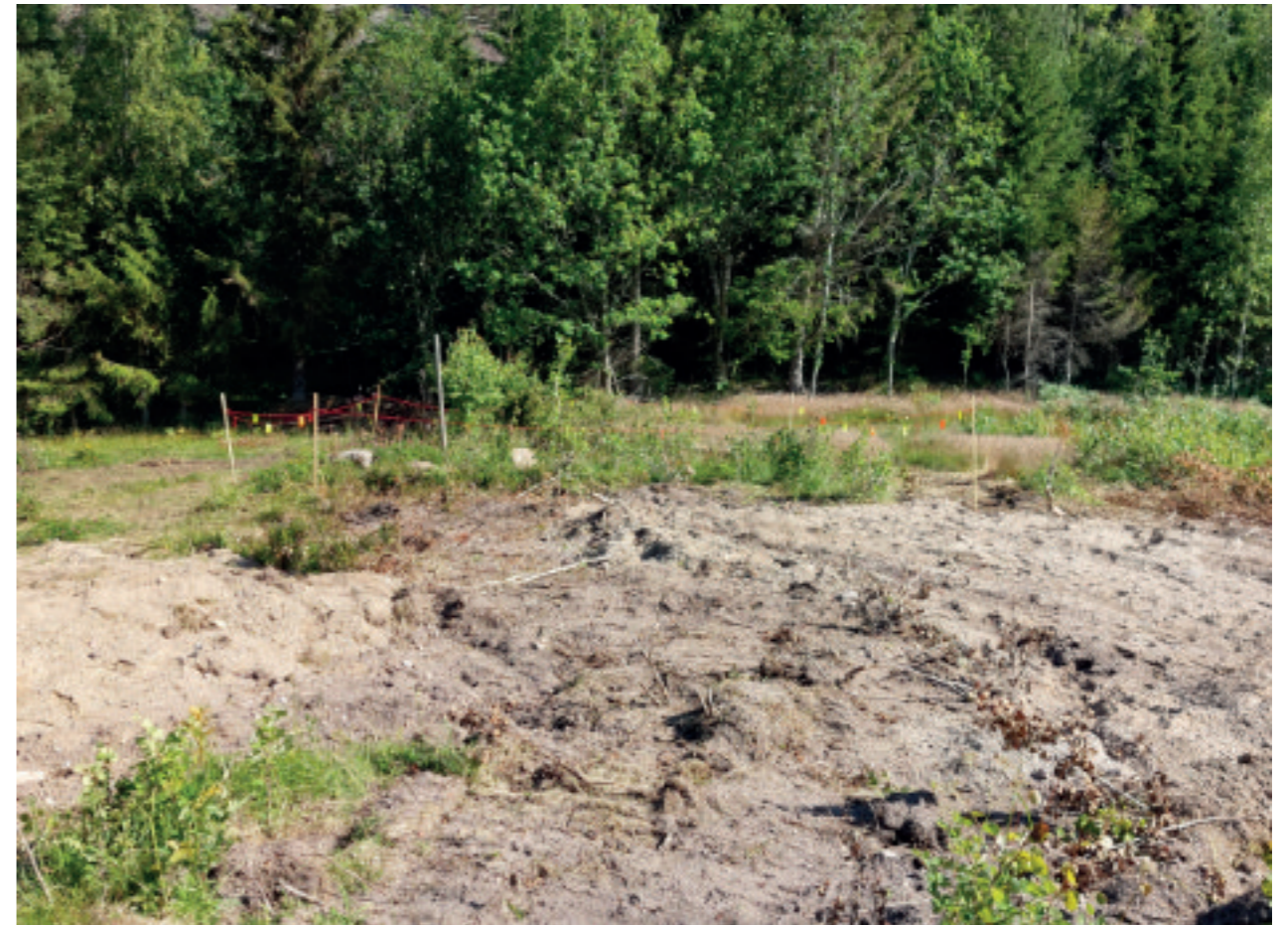
Illustration 1:2. Vy mot domarringen. Bild från översiktlig skadedokumentation. Bilden tillhandhållen av Länsstyrelsen i Västra Götaland.
