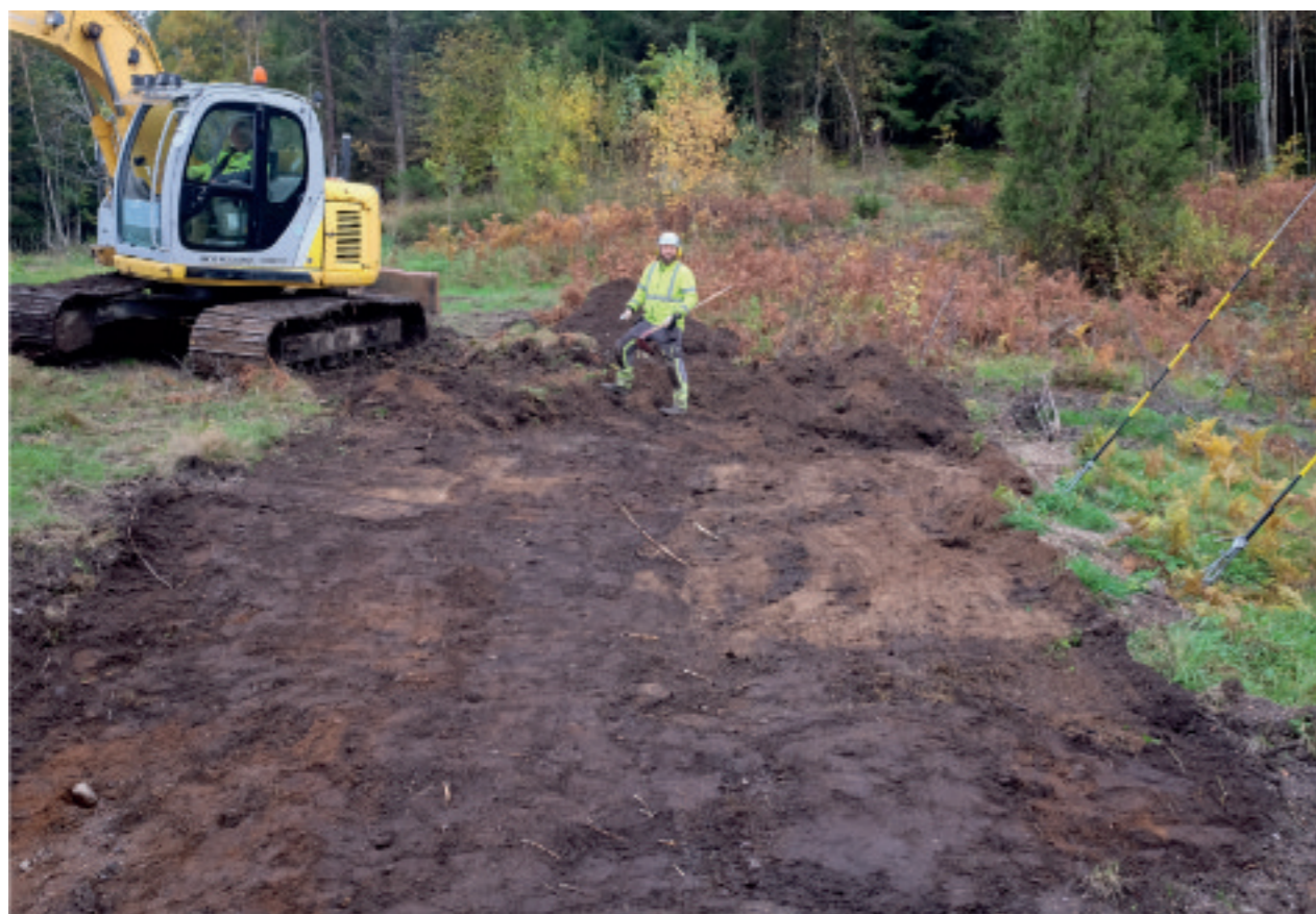
Illustration 1:7. Översikt, del av yta 2 efter avbanning. Denna yta hade störts av schaktning vid upptagning av hål för nya stagfästen. Ytan ingår delvis i den nyregistrerade boplatsen L2024:6480 och ansluter till i norr till härden L2024:6485. Foto mot söder.
