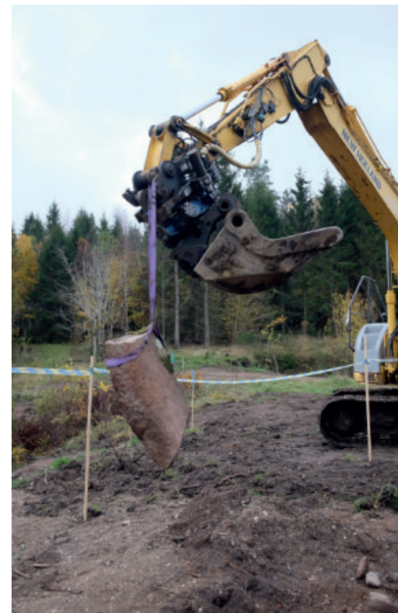
Illustration 1:8. Sten 7a på väg att lyftas på plats av grävmaskinist Ulf Andersson. Foto mot sydväst.
