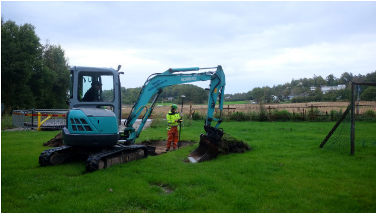
Illustration 15. Schakt 18, i den sydvästra delen av området. Här framkom anläggning 3. Ytan där schakt 18 och 19 togs upp har registrerats som L2025:5447 Boplatssområde. Foto mot norr.
