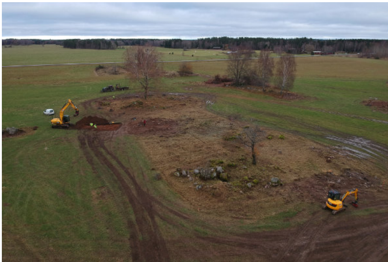
Illustration 3. Drönbild över undersökningsområdet. Närmast kameran står den lilla grävmaskinen vid skadan där A 16 förut fanns. Den stora grävmaskinen har börjat ta upp sektion 1 och 2 väster om boningshuset, vilket låg under det skadade och borttagna röset KUL 22. Foto mot norr. Bilden publiceras med spridningstillstånd från Lantmäteriet.
