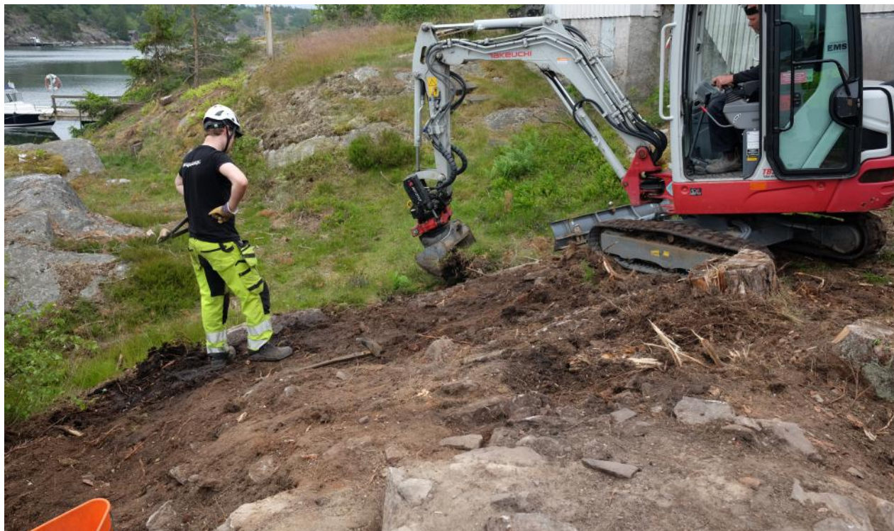
Illustration 9. Ytan runt husgrunden banades skiktvis ner till undergrund eller berghäll där maskinen kom åt, för att hitta den yttre avgränsningen på trankokerilämningen. Foto mot söder.
