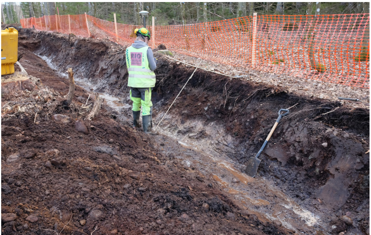
Illustration 2:32. Bilden visar södra ändan av sektion 37, 39 och 41. Här tog vi upp ett långt djupschakt för om möjligt reda ut lagerförhållandena. Stig står vid profil nr 6. Fotografi taget mot öster.
