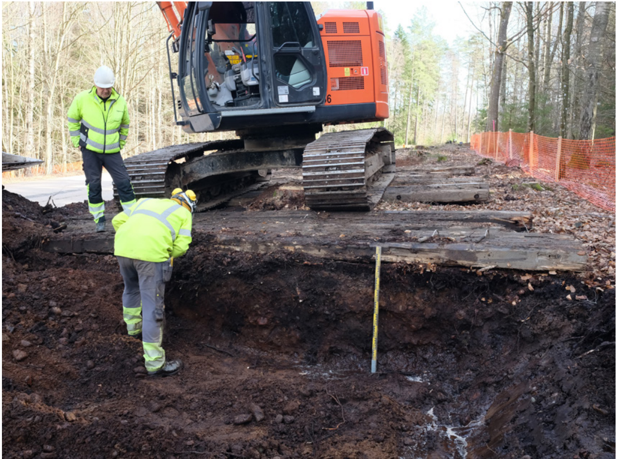
Illustration 2:31. Profil mellan sektion 36 och 37. Notera hur vattnet trycker på i högra delen av sektionen. Fotografi mot öster.
