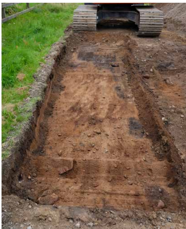
Illustration 1:6. Avbaning i väggkroppen, inom den norra delen av undersökningsområdet vid L1969:2530. Det var svårt att hitta rätt nivå och avgöra när vi kommit ner till orörda naturliga lager. Den röda grusiga sanden visade sig vara påförd i denna sektion; närmast grävmaskinen har kokgroppen anläggning 50 precis blottats. Foto mot söder.
