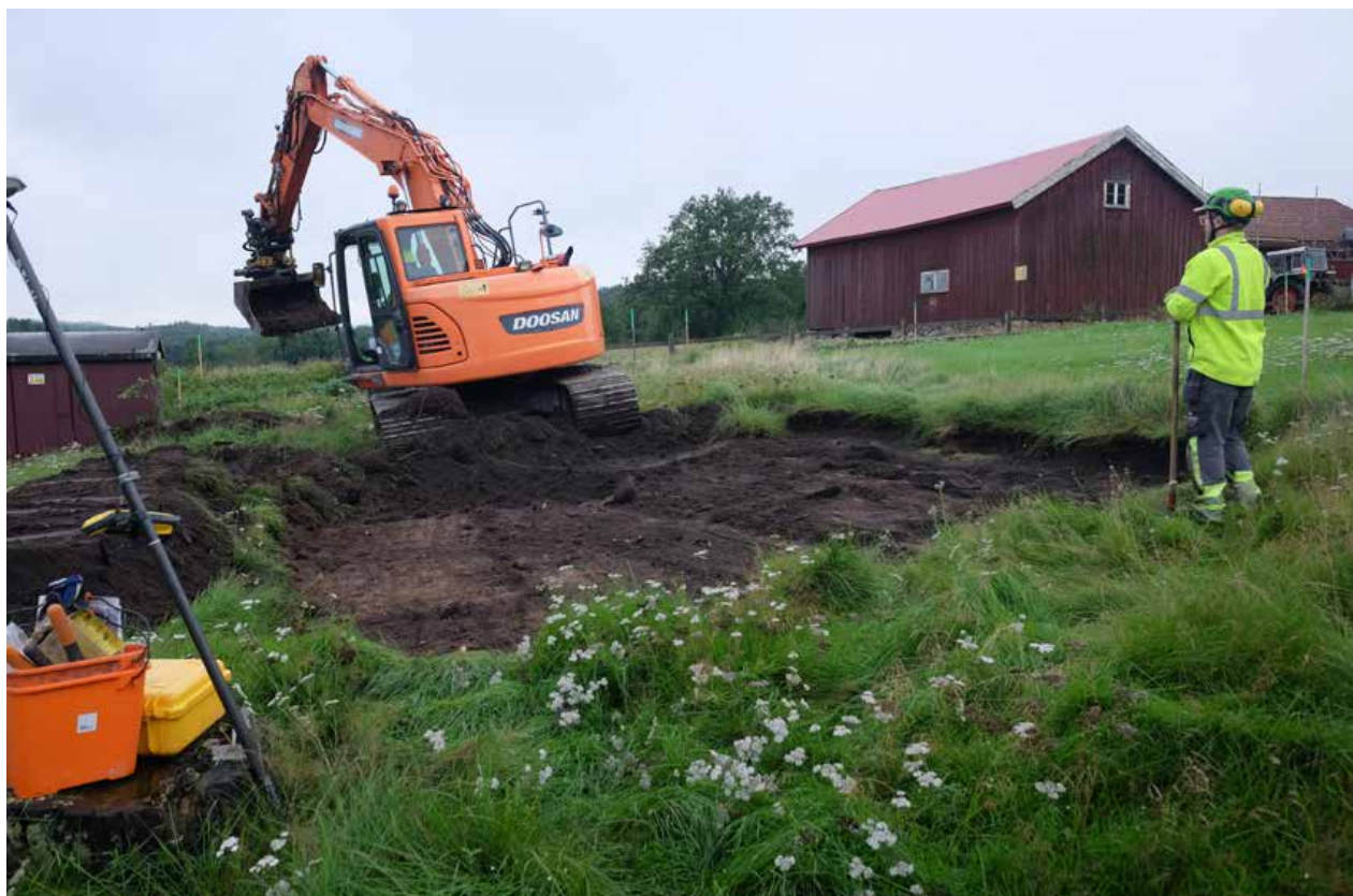
Illustration 1:5. Avbaningen inom det norra undersökningsområdet, intill L1969:2530, har precis påbörjats. Olofövernakar. Foto mot nordväst.
