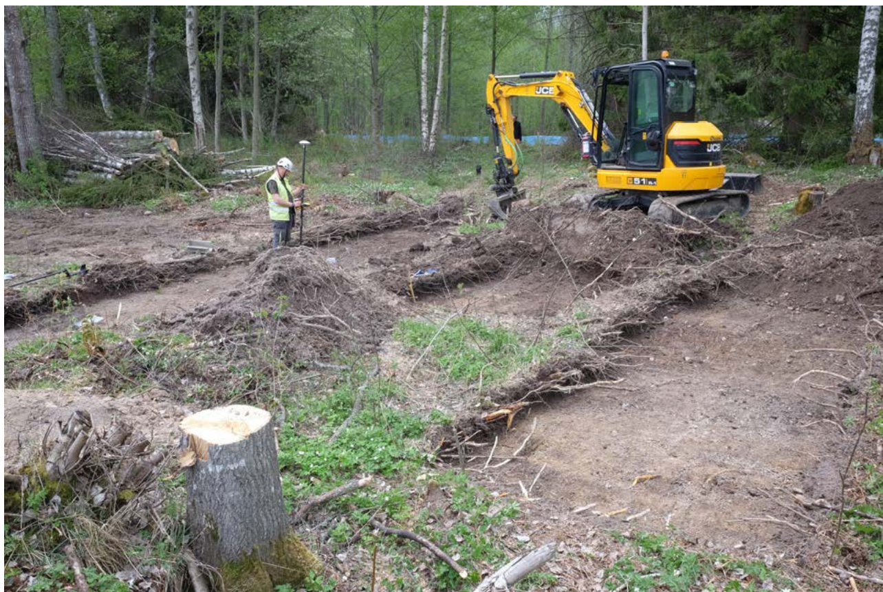
Illustration 29. Schakten vid L2022:3290. Olof mäter in anläggning 20 i de sammanslagna schakten 30, 31 och 32. Närmast i bild är schakt 34 och 33. Bakom grävmaskinen ligger schakt 35. Foto mot sydväst.
