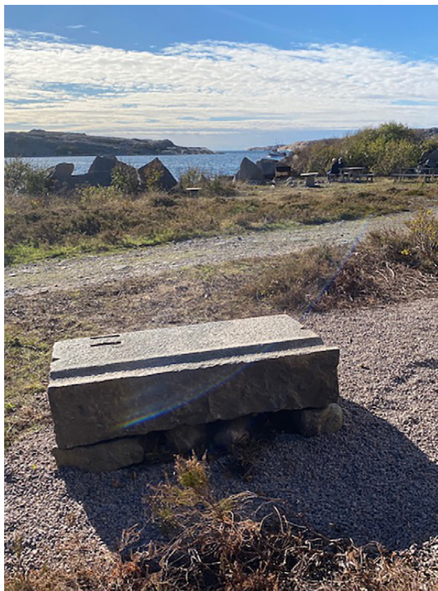
Illustration 20: På ovansidan av berättarbänken i Sibirien, en så kallad kajskoningsten, syns rännan som skulle samla upp och leda bort vatten från högt vattenstånd och vågor. Foto: Granitkusten.
