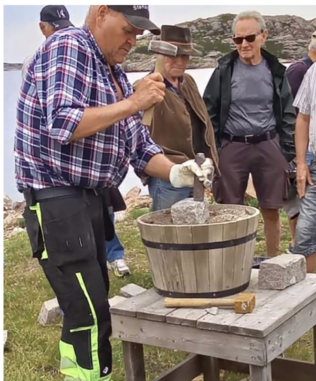
Illustration 29: Christer Olsson demonstrerar tillhuggning av gatsten på sedvanlig putstunna under invigningen i Lysekil. Fotograf: Monika Brohed.
