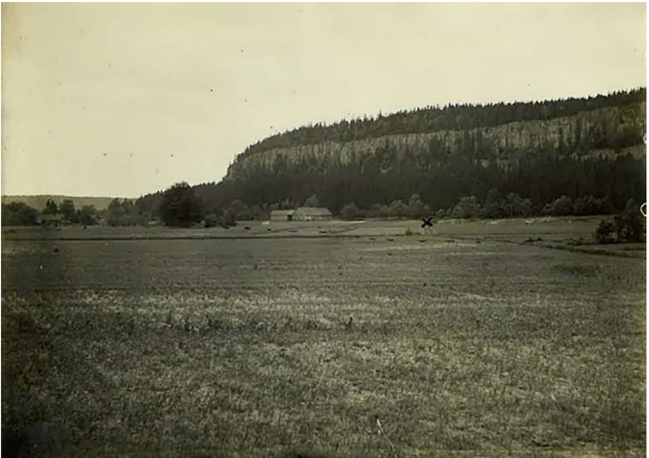
Illustration 2. Vy från Vänersnäs. Boplatsen Änden (L1964:7393), strax söder om utredningsområdet, med Halleberg i fonden. Bilden är tagen 1920 av Alin vid ett av hans besök till Vänersnäs och dess stenåldersboplatser. Foto taget mot sydväst. Från Göteborgs stadsmuseums samlingar.
