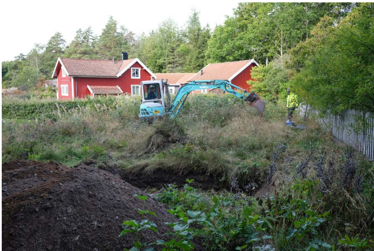
Illustration 7. I förgrunden schakt 7. Därbakom har Erik och grävmaskinist Jocke påbörjat schakt 8. Bortom schakt 8 finns schakt 1. Foto mot väster.
