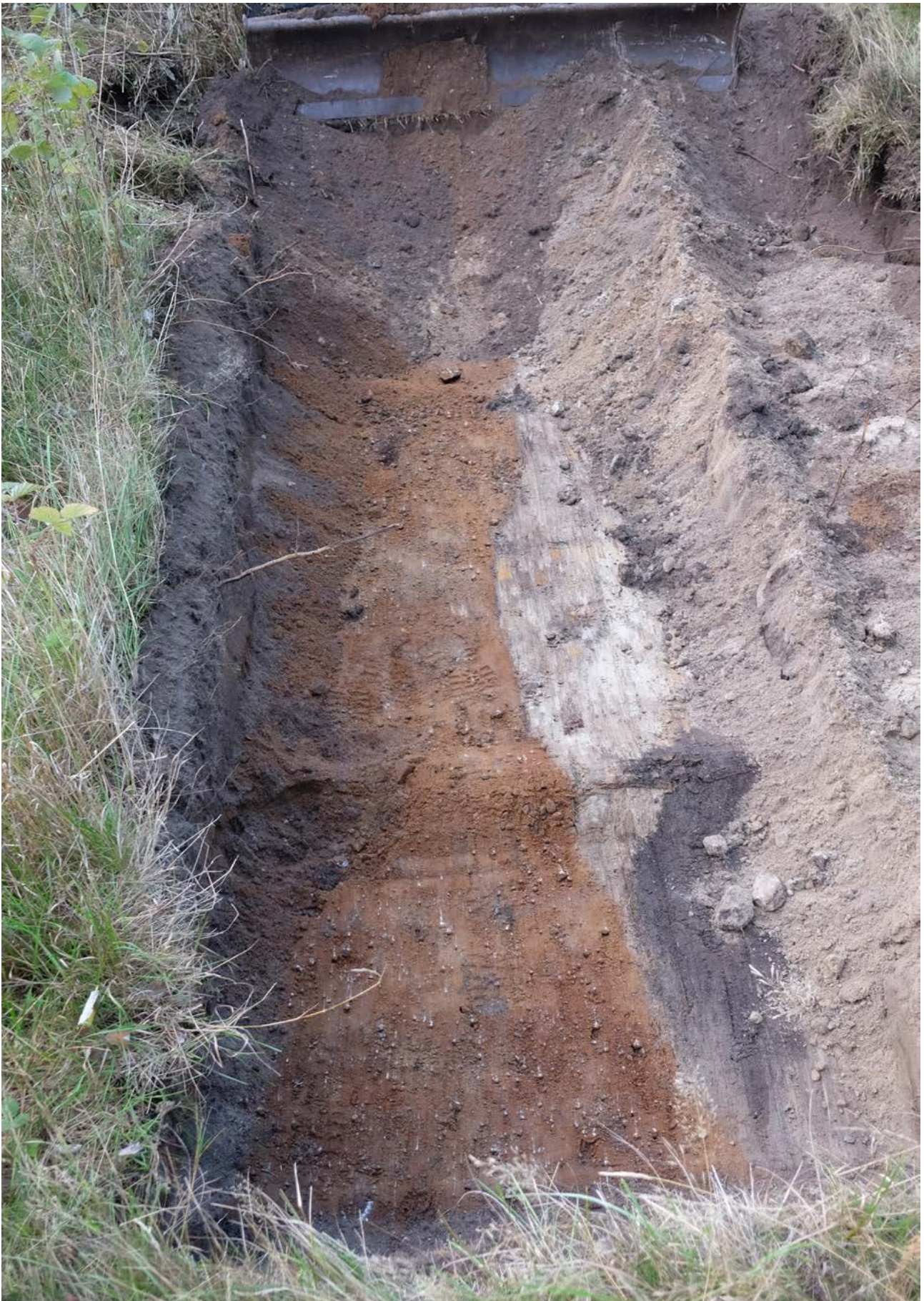
Illustration 18. Störningen i schakt 1, eventuellt dagvattenledning från gamla skolan. Foto mot söder.
