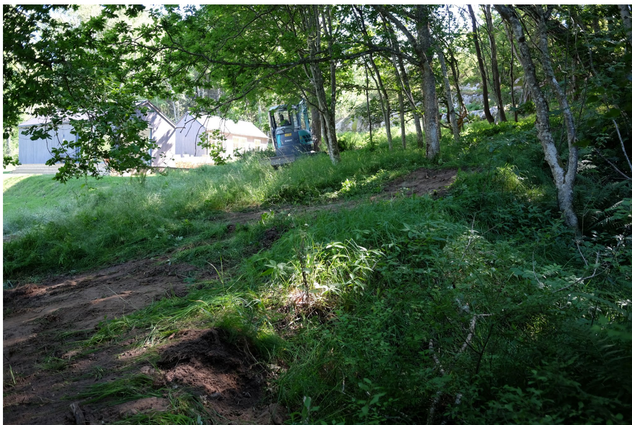
Illustration 6. Till höger i bild anas det igenväxta grustaget. Schakten som togs upp närmast grustagskanten är igenfyllda. Grävmaskinen står vid schakt 7. Foto mot söder.
