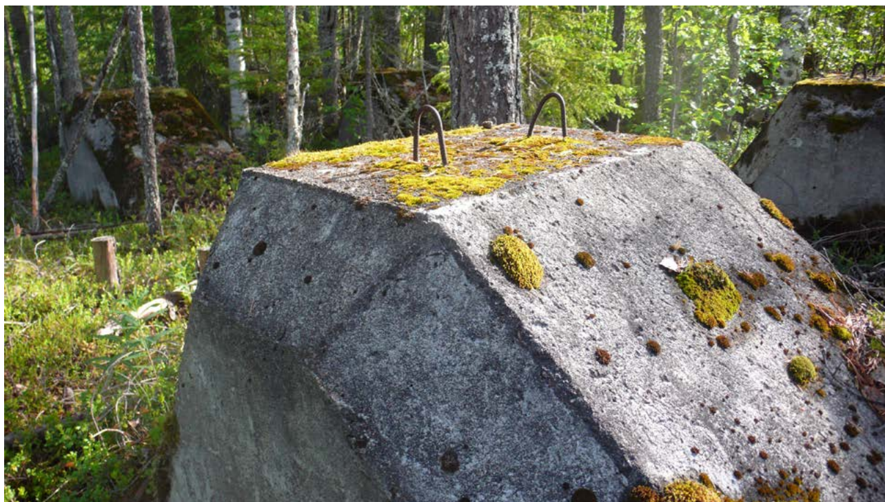
Illustration 22. Stridsvagnshinder i betong L2019:5795. Hindren är ställda i tre rader på ömse sidor om väg och flankeras i öster och väster av de två bunkrarna L2021:7589 och 7590. Foto mot nordost.
