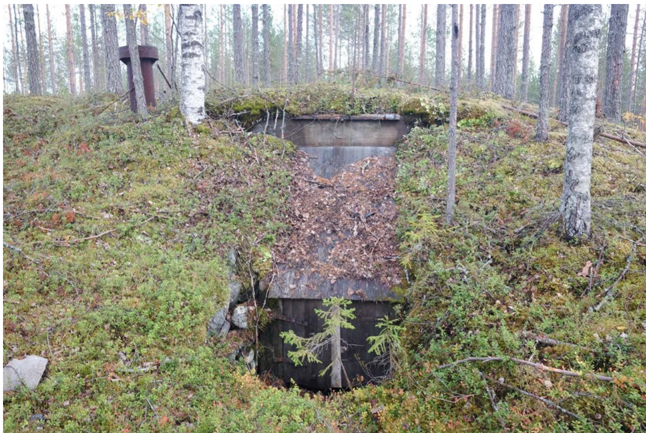
Illustration 24. Ingång till bunker L2021:7590. Foto mot sydost.
