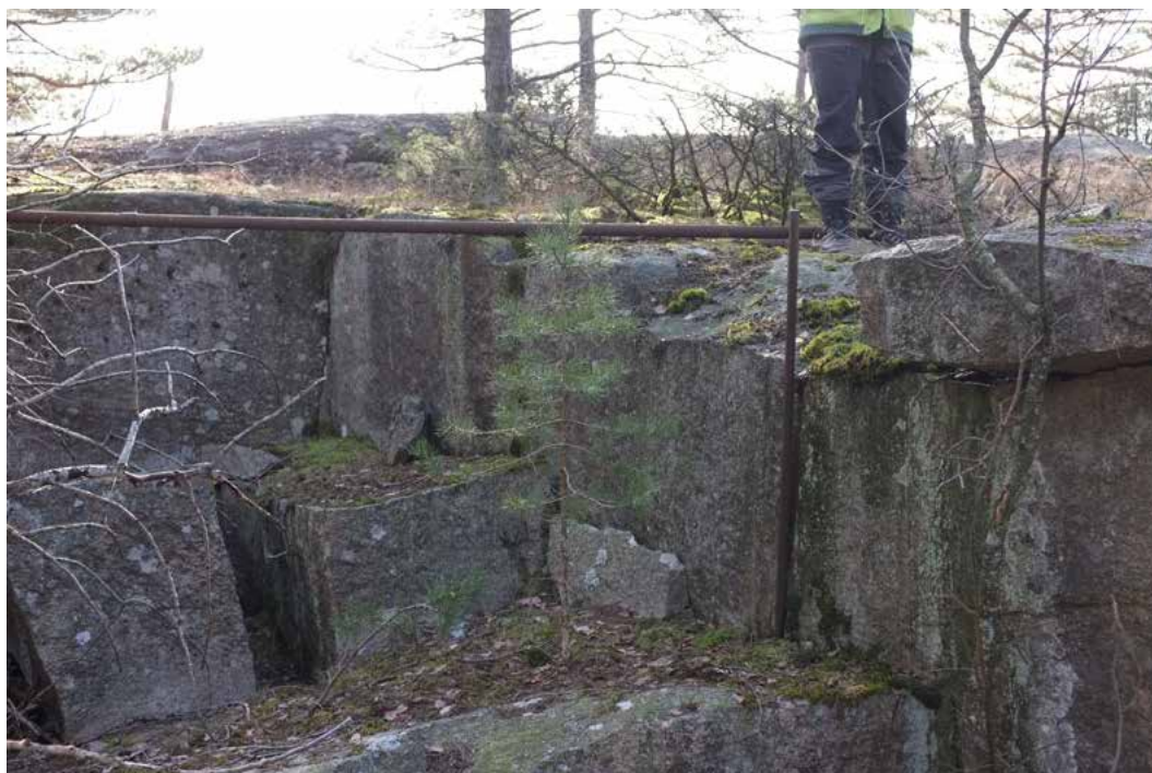
Illustration 59. Ett kvarsittande borr och en kvarliggande tryckluftsledning, Tanum 3 / Prästesäm.
