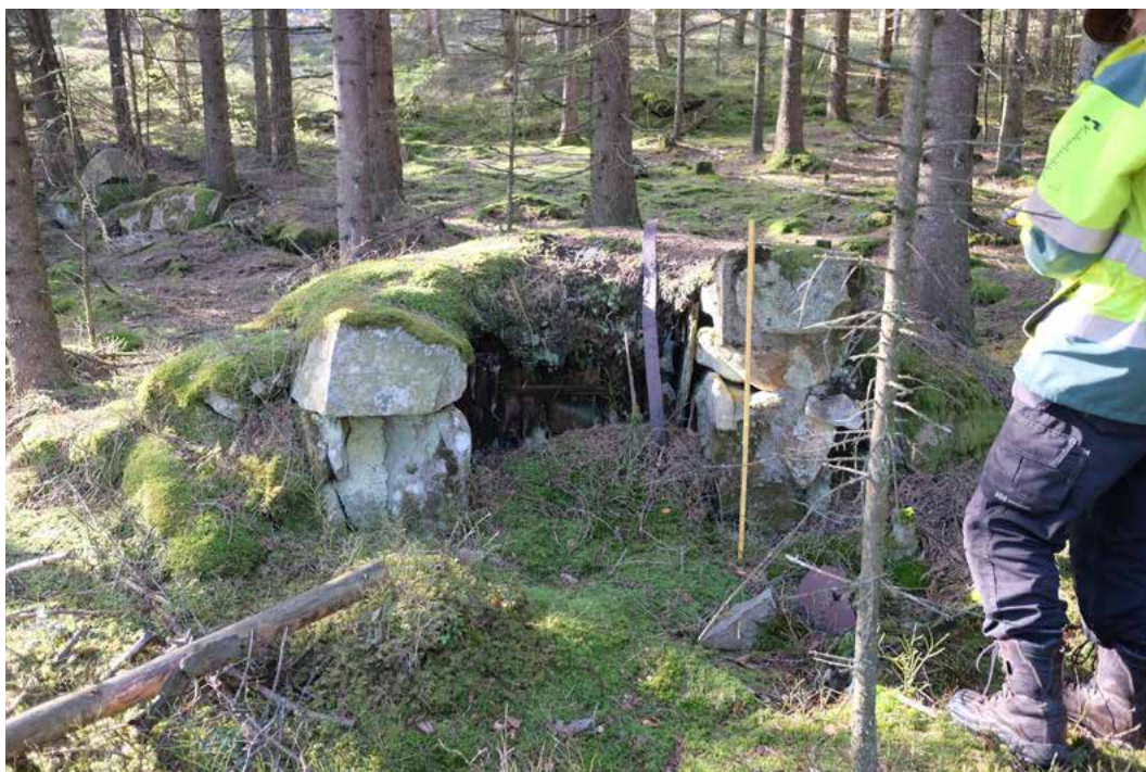
Illustration 75. Stenkistan som ska ha använts för förvaring av krut. Den är byggd av huggen sten samt förstärkt med betong vid öppningen och gavlarna. Taket har varit belagt med tjärpapp. Eventuellt har den varit brukad även under beredskapstiden; i närheten finns militära försvarslämningar i form av stridsvagnshinder. Munkedal 4 / Klevberget.
