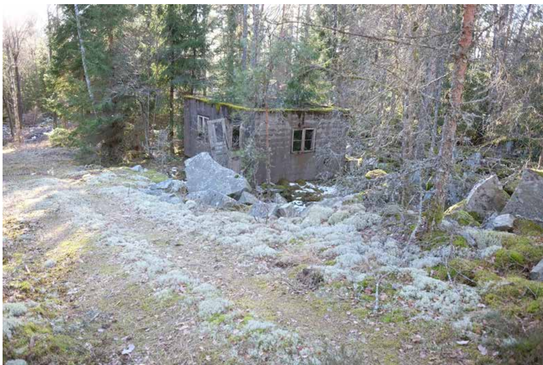
Illustration 76. Byggnaden vid storbrottet Munkedal 5 / Hällevad storbrottet. Huset är uppfört av betongblock samt isolerad invändigt med plattor. Fönstren och dörrarna bär spår av grön färg. Precis intill går vägen som leder in i området, och sedan fortsätter upp till storbrottet.
