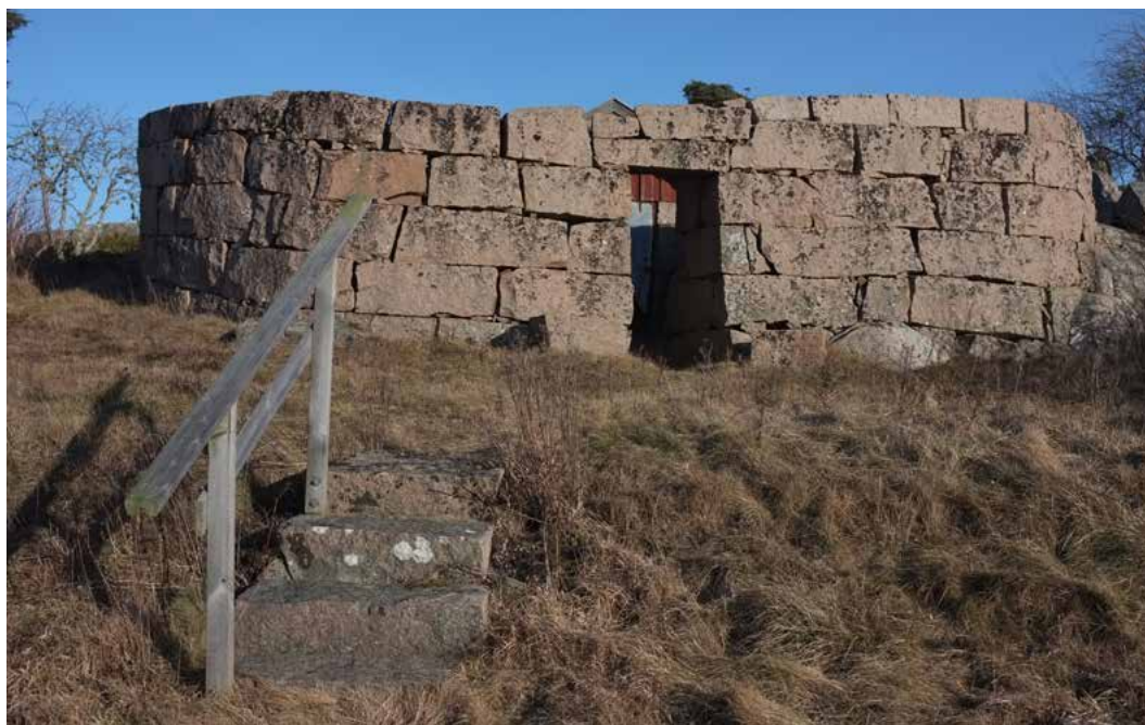
Illustration 43. Vid Amdalsbryggan står kruthuset kvar, med sin imponerande skyddsmur. 16 Amdalsbrottet, Tanums kommun.
