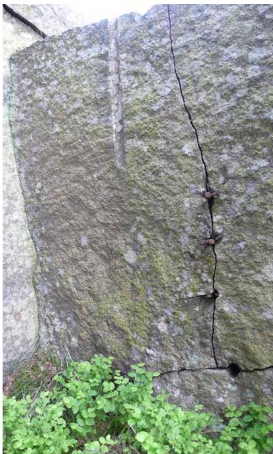
Illustration 20. Borrhål med remmare och kvarsittande rundkilar med bleck. Mer sällan har man behövt borra och kila horisontellt, troligen mest när berget självt varit svårare att hantera. Här verkar det också som att resultatet inte blev det önskade. Hamburgsund 3 / Ejgde.
