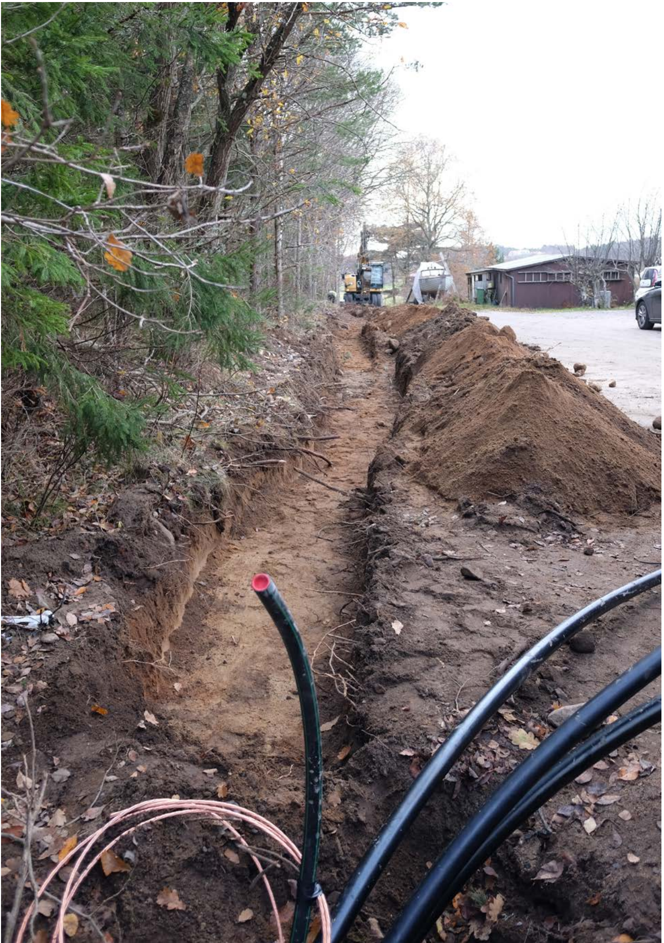
Illustration 11. Översikt av schakt 7. I den norra delen framkom en del stenartefakter tillsammans med mer nutida material. Schakt 1 kan ses som en mörkfäring ungefär mitt i schaktet. Foto mot sydväst.
