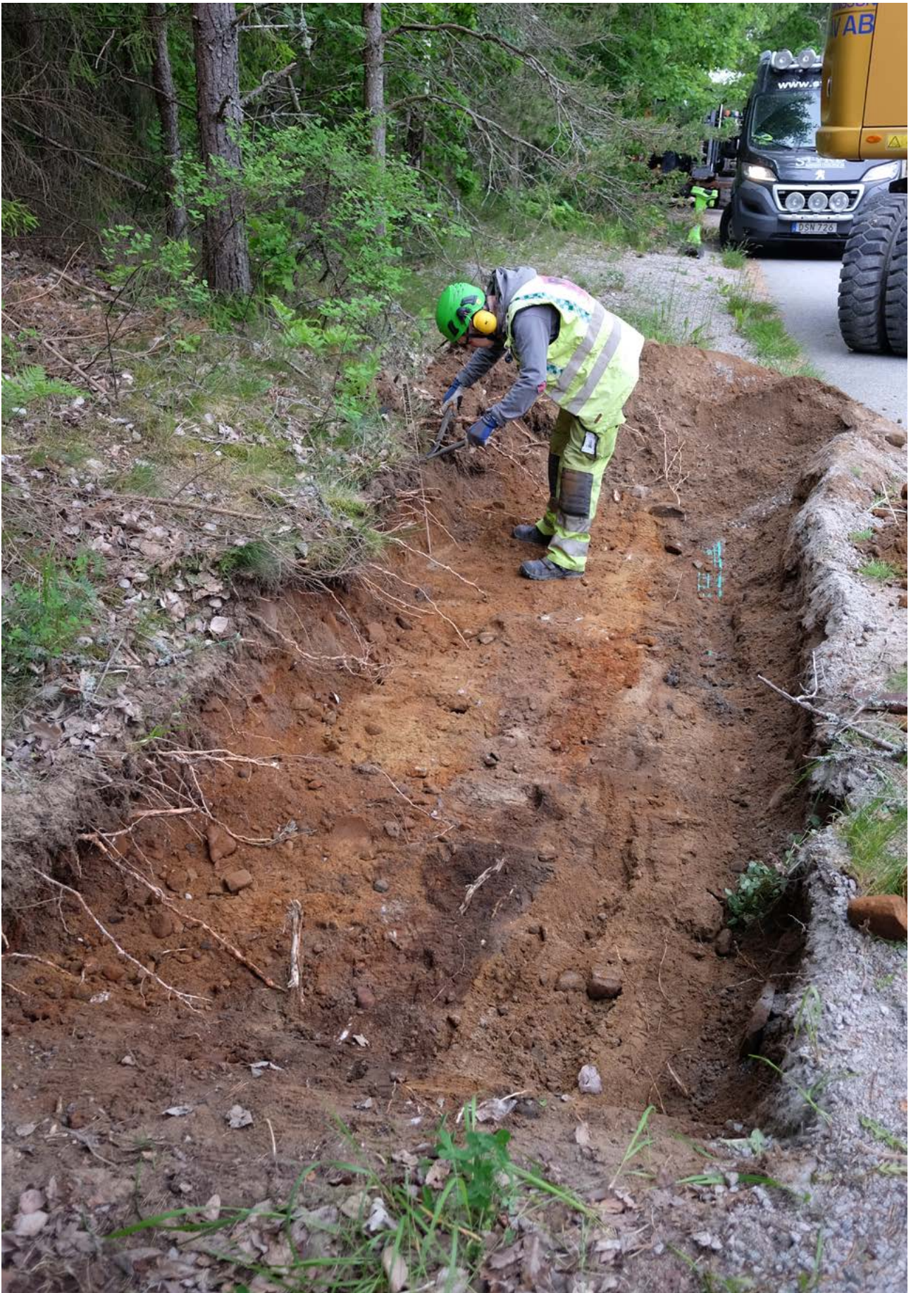
Illustration 5. Schakt på cirka 0,5 meters djup. Fiberkabelschaktet syns till höger i bild. På grund av kabeln fortsatte schaktningen öster om denna. Foto mot sydväst.
