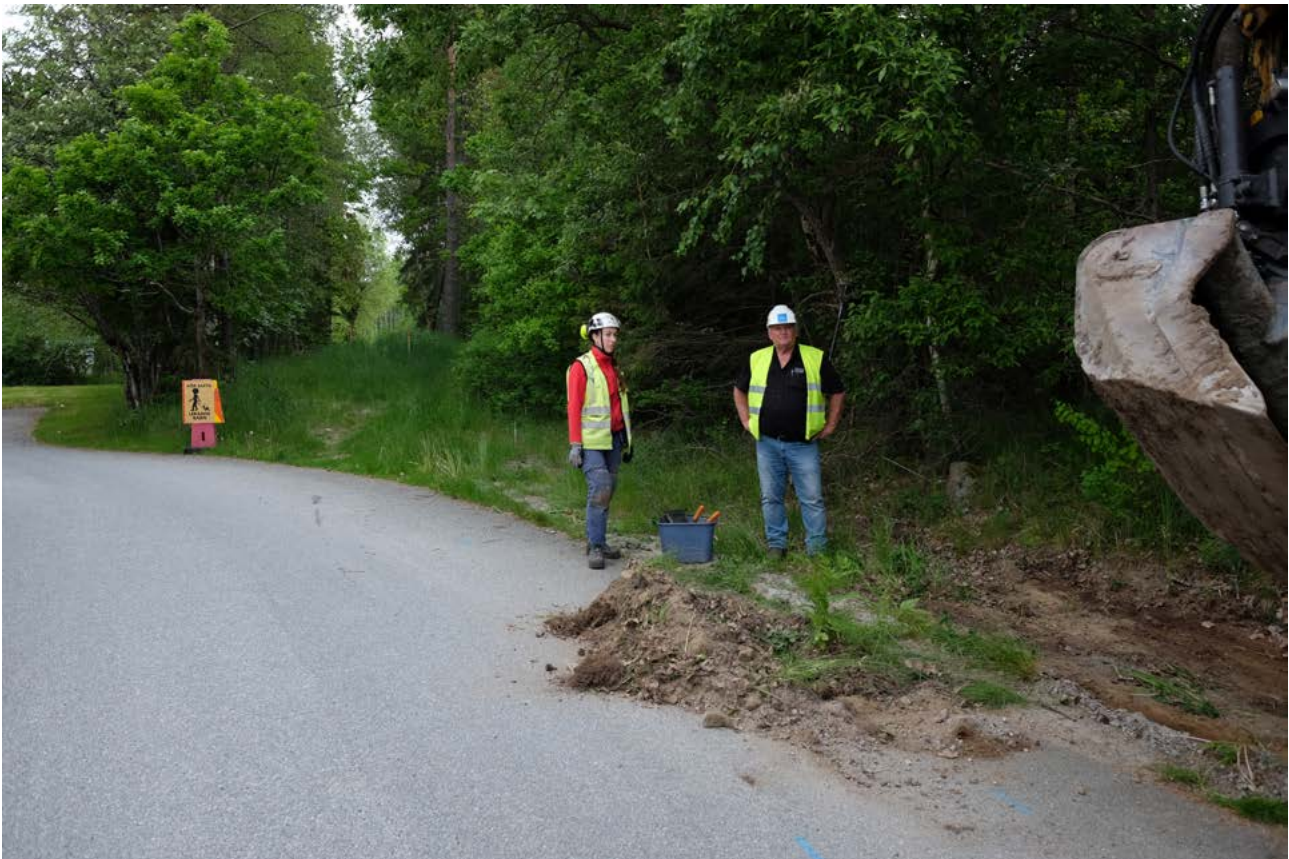
Illustration 4. Schakt 1 tas upp på östra sidan av vägen mittemot hyreshuset. Linda och Jonh-Erik Thorén övervakar arbetet. Foto mot nordost.
