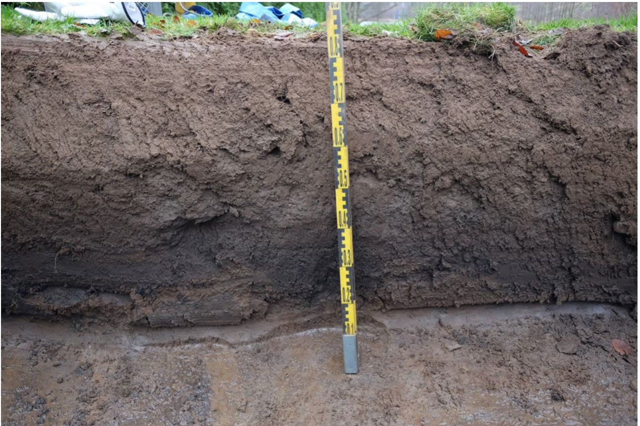
Illustration 4. Profil i den södra schaktväggen. Lagerbeskrivning: Humös lera 0-0,40; brun humös lera 0,40-0,65; siltig lera i botten. Foto mot sydost.
