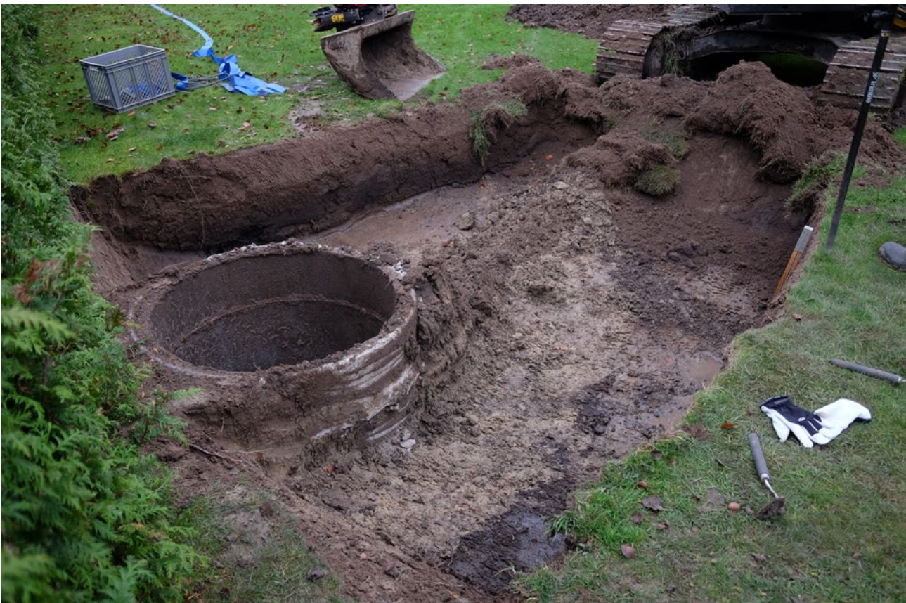
Illustration 3. Översikt av schaktyta. Den närmaste delen av ytan är schaktat till ett djup av 0,8 meter. Foto mot sydväst.
