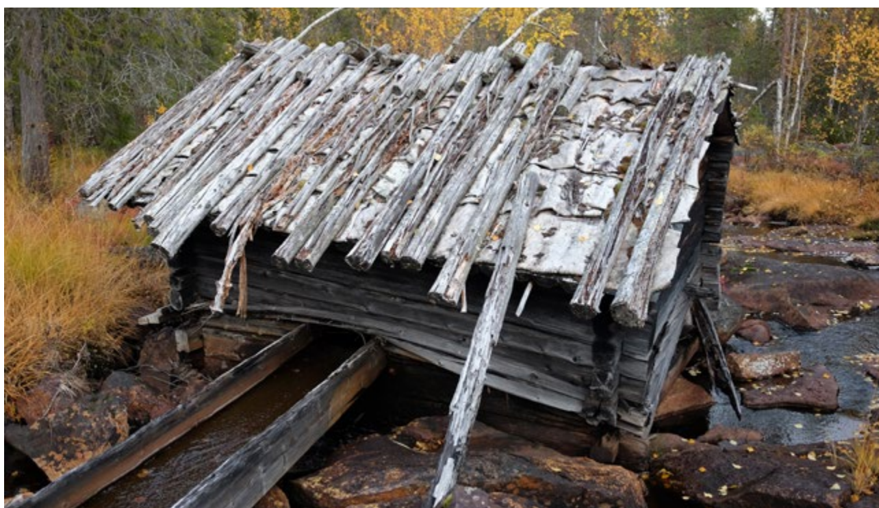
Illustration 4. Kvarnens tak är intakt, men i mycket dåliga skick. Foto mot sydöst.
