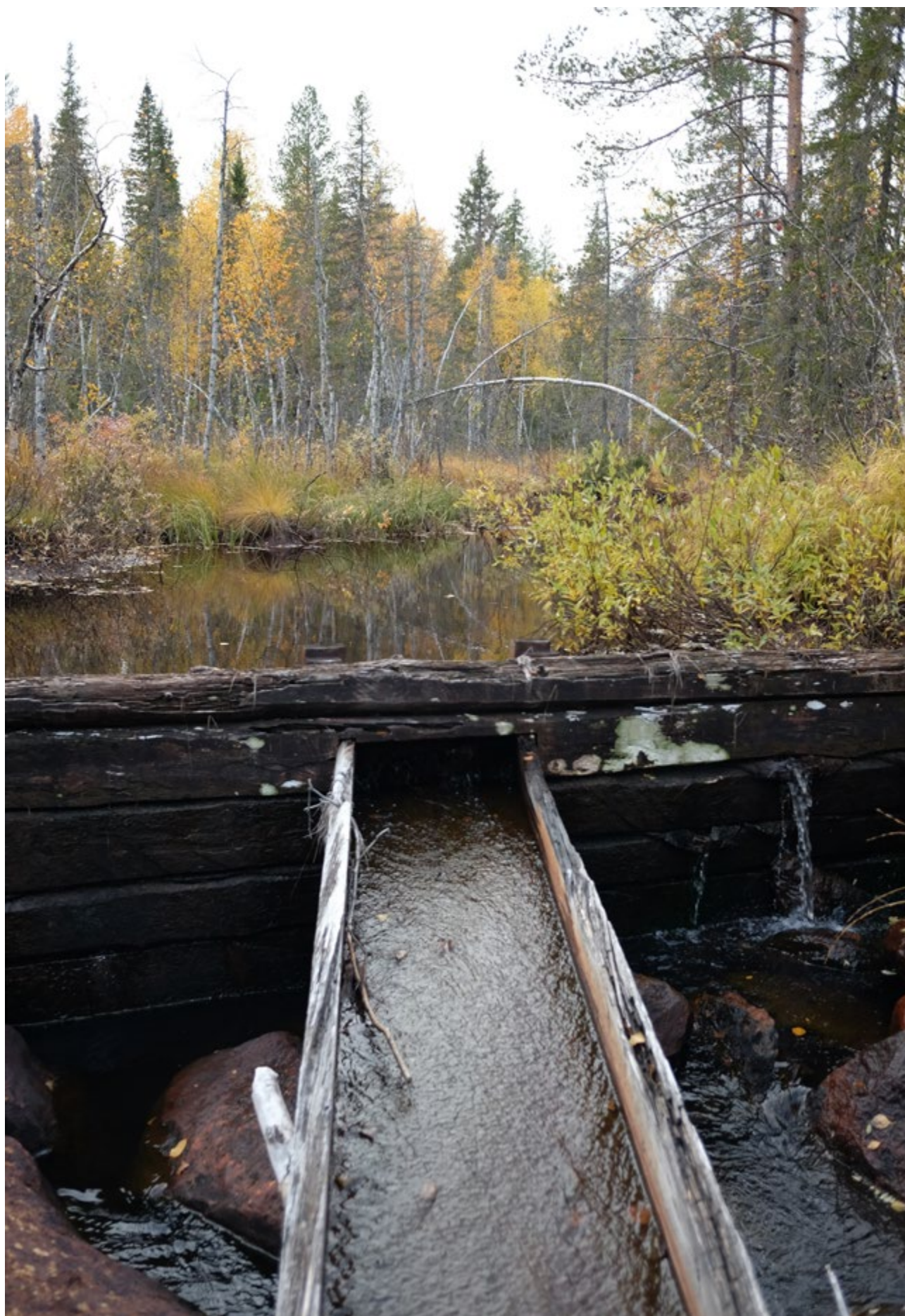
Illustration 5. Ovanför kvarnen finns ett timrat dämme samt en ränna som leder vatten in i kvarnen. Foto mot nordväst.
