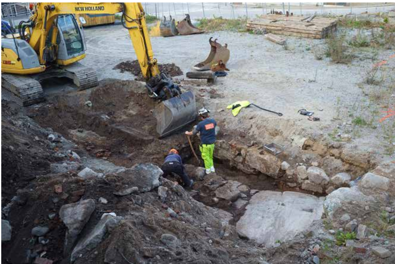
Illustration 1.8. Undersökningens andra dag, oktober 2015. Notera grusmassorna som fyller upp ytan, samt markduken som sticker fram i schaktkanten, och separerar gruset från underliggande brandlager. Anna och Oliver har påbörjat schaktningen. Foto mot sydväst.
