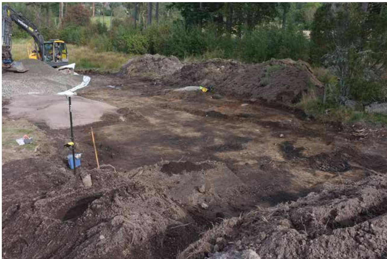
Illustration 11. Översikt över sektion 15, med den stora kulturlagerytan framrensad. Till vänster har arbetet med en tillfällig arbetsväg påbörjats. Foto mot nordöst.
