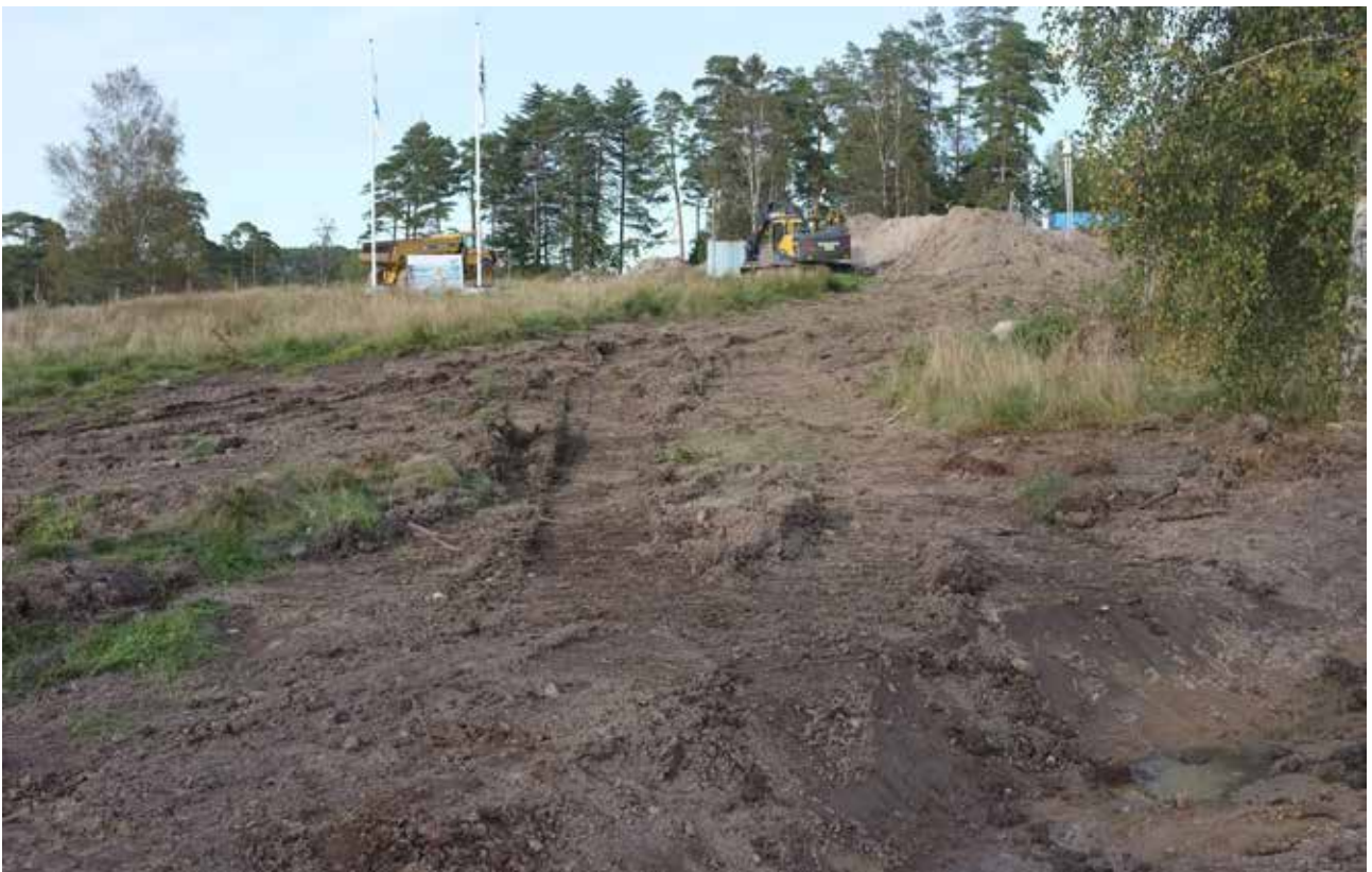
Illustration 28. Körsador från nya infartsvägen till vattenverket fram till den tillfälliga vägen över bergimpedimentet i öst. Foto mot nordöst.
