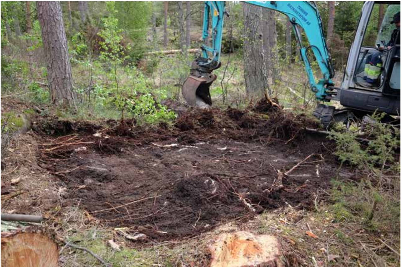
Illustration 9. Även schakt 8 togs upp nedanför berg, och var förhållandevis torrt med en undergrund av sand. Liksom schakt 7 var det fyndtomt. Schakt 7 syns inte men finns i bakgrunden centralt i bild, mot berget. Foto mot sydost.
