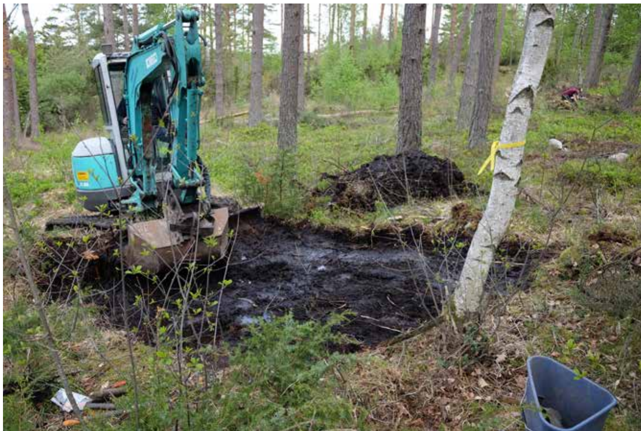
Illustration 6. Avbaning pågår i schakt 2. I bakgrunden till höger syns Lisa vid ruta 1 i schakt 1. Foto mot norr.
