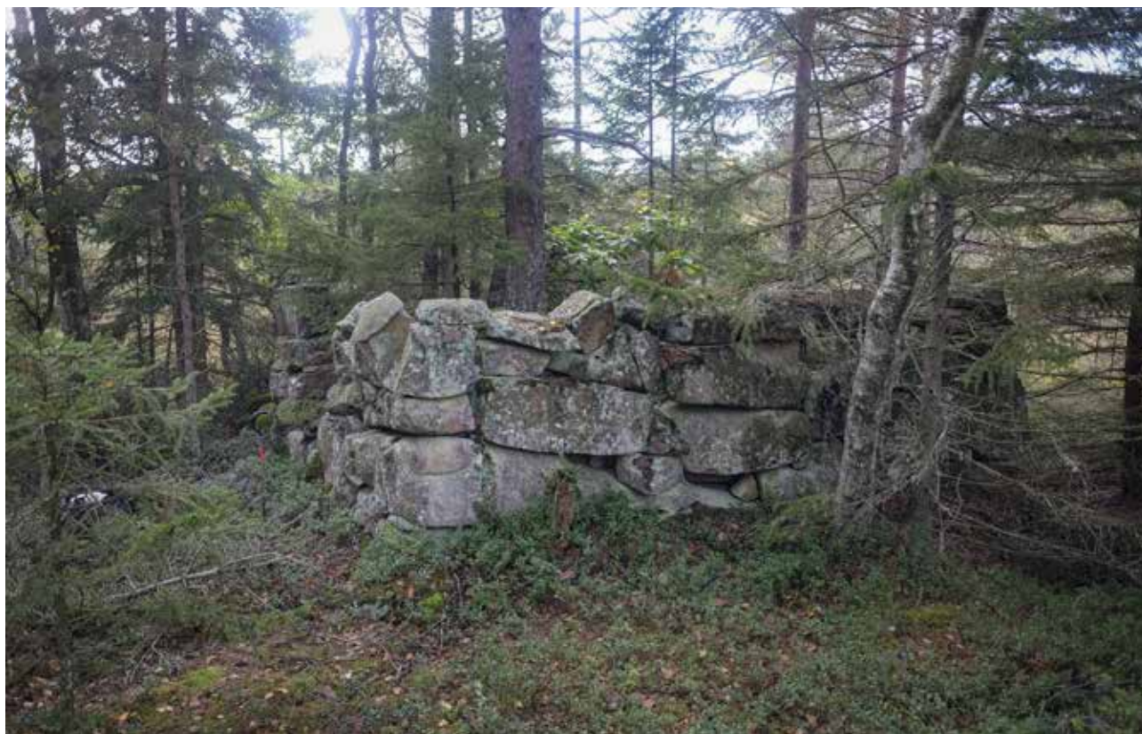
Illustration 27. Torvtorkningslada, L2020:9401, relativt centralt i området. Bakom husgrunden syns Långemyren där torven brutits. Runt Långemyren finns ytterligare fyra torvtorkningslador. Foto mot sydväst.
