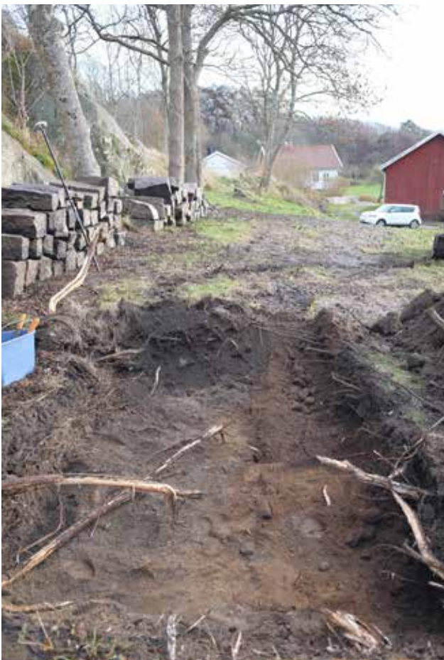
Illustration 13 (ovan vänster). Profil i schakt 3. Foto mot väst. Illustration 14 (vänster). Schakt 4, 200 m söder om schakt 1-3, med en undergrund av sand istället för skalgrus. Foto mot sydöst.
