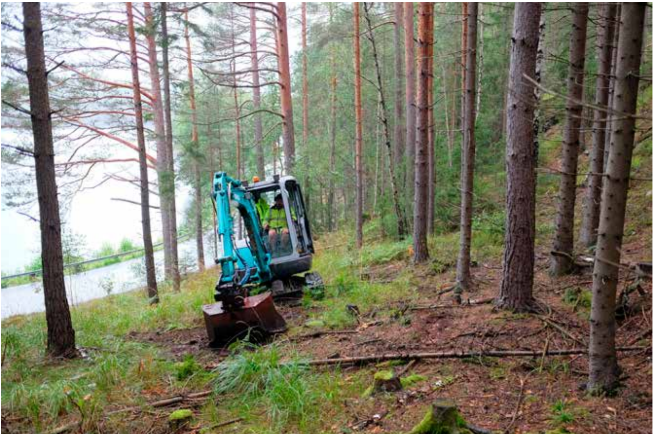
Illustration 38. Boplatsläge 2. Jocke lägger igen schakt 11. Kvarnekastjärnet i bakgrunden. Foto mot nordväst.
