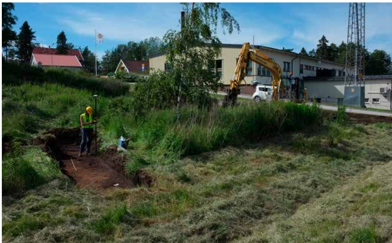
Illustration 4. Schakt 4 mäts in av Linda. I bakgrunden syns räddningstjänstens lokaler. Foto mot nordväst.
