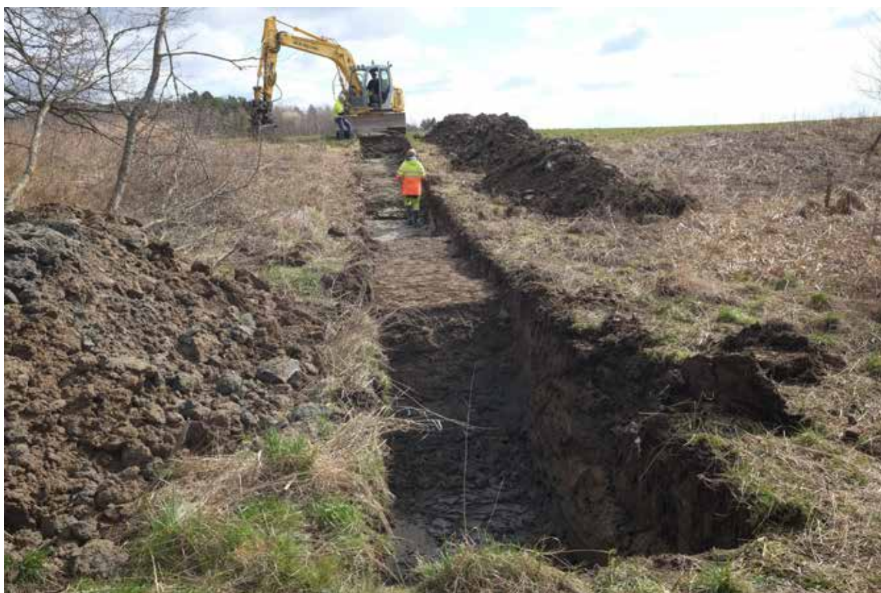
Illustration 4. Även schakt 17 togs upp som ett kombinerat lång- och djupschakt i älvbrinken. Linda och Stig dokumenterar schaktet. Foto mot sydöst.
