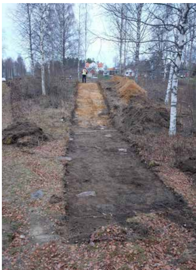
Illustration 6. Schakt 8. Fotografen står nere vid vattendraget Röjdan. Närmast i bild syns stenar som troligen utgjort fundament till en dansbana. Andreas står på toppen där en grund till en byggnad framkom, anläggning 13, vilken registrerades som L2018:1512. Foto mot norr.
