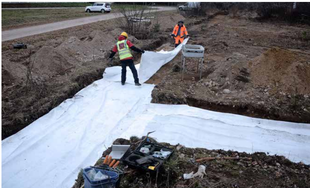
Illustration 4. Andreas och Anders lägger ut markduk i schakt 1 och 4 inom Fryksände 379. Foto mot nordost.
