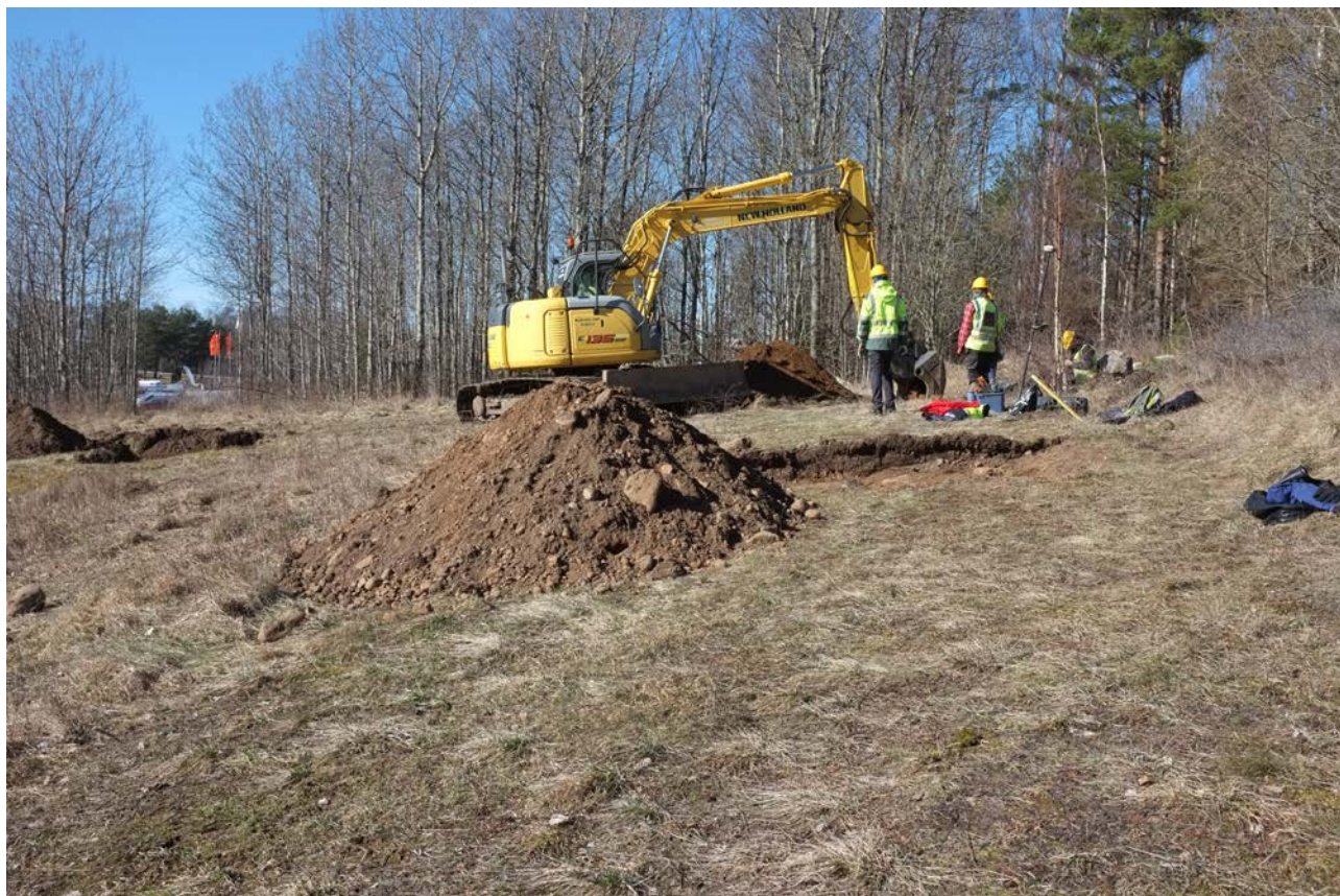
Illustration 2: (O217): Upptagning av schakt 7, schakt 5 syns närmast i bild och schakt 6 till vänster. Foto mot nordväst.
