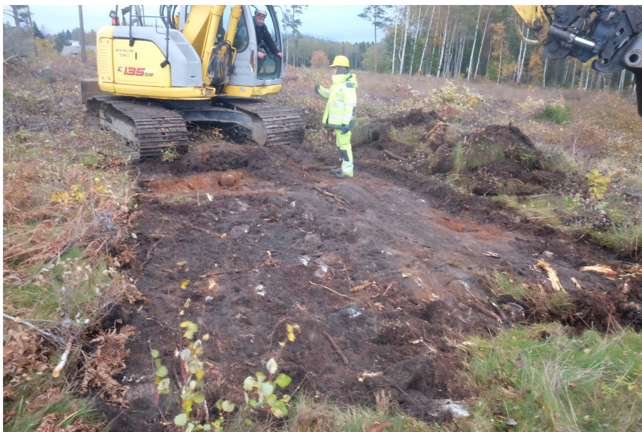
Illustration 2: Stenläggningen på östra sidan av Naverstad 273 frilagd.
