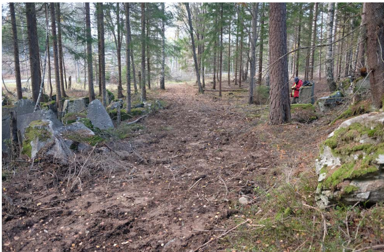
Illustration 18. Skada på stridsvagnshinder inom KUL 21, område C. Flera hinder är flyttade efter att markarbeten utförts. Foto mot nordväst.
