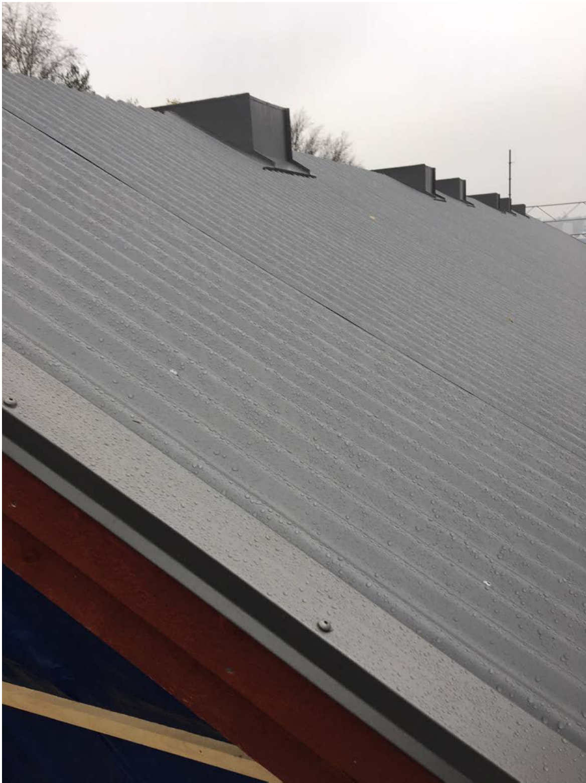
Bild 19. Närbild plåttak. De sex plåthuvorna är placerade på samma ställen som de tidigare takryttarna.
