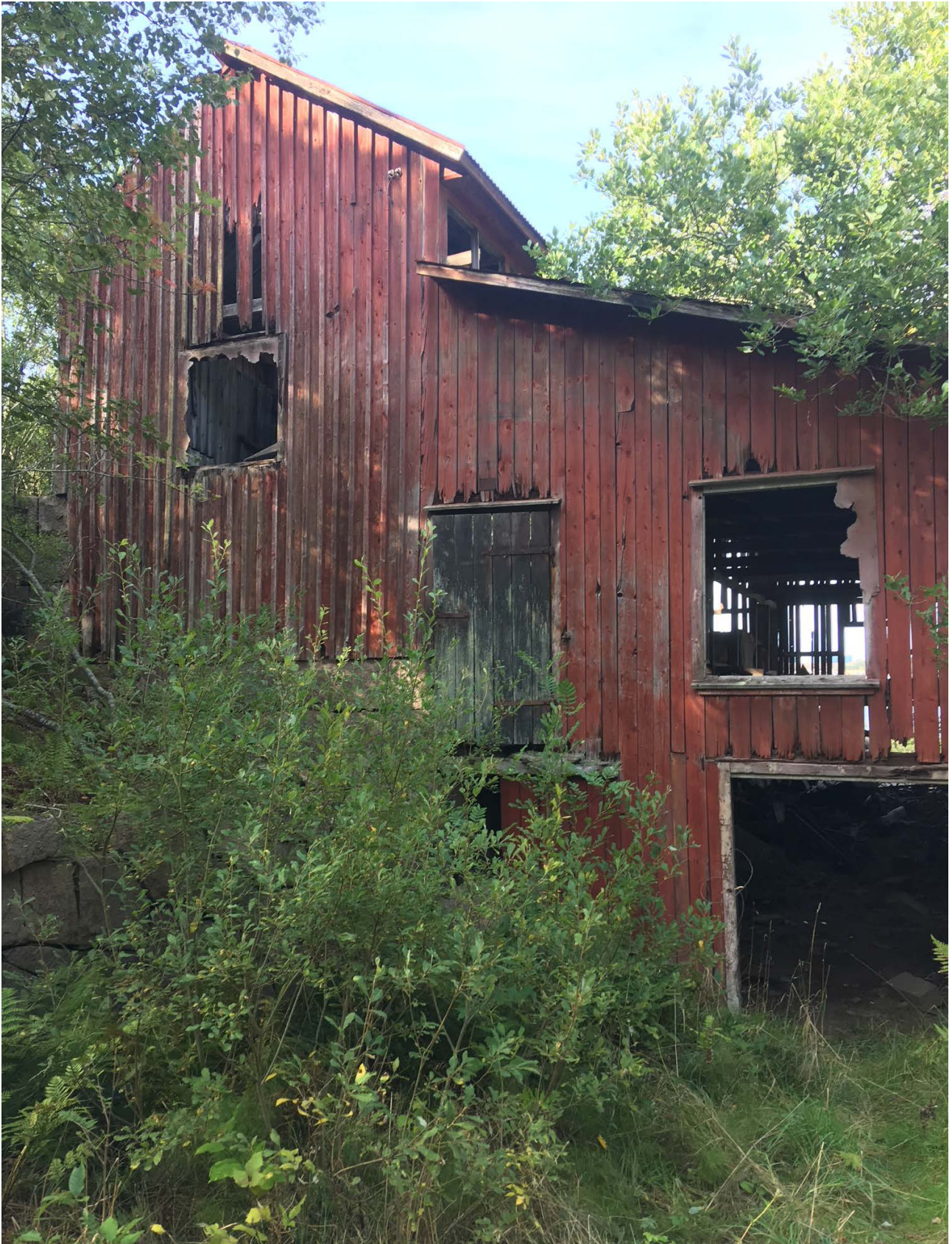
Bild 1. Östra gaveln med den övre delen med sadeltak och den nedre delen med pulpettak.
