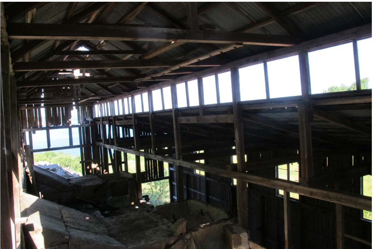
Bild 5. Interiör övre plan och mellanplan. Takstolarna var i ganska gott skick, några sparrar och hanbjälkar behövde bytas samt åsarna.
