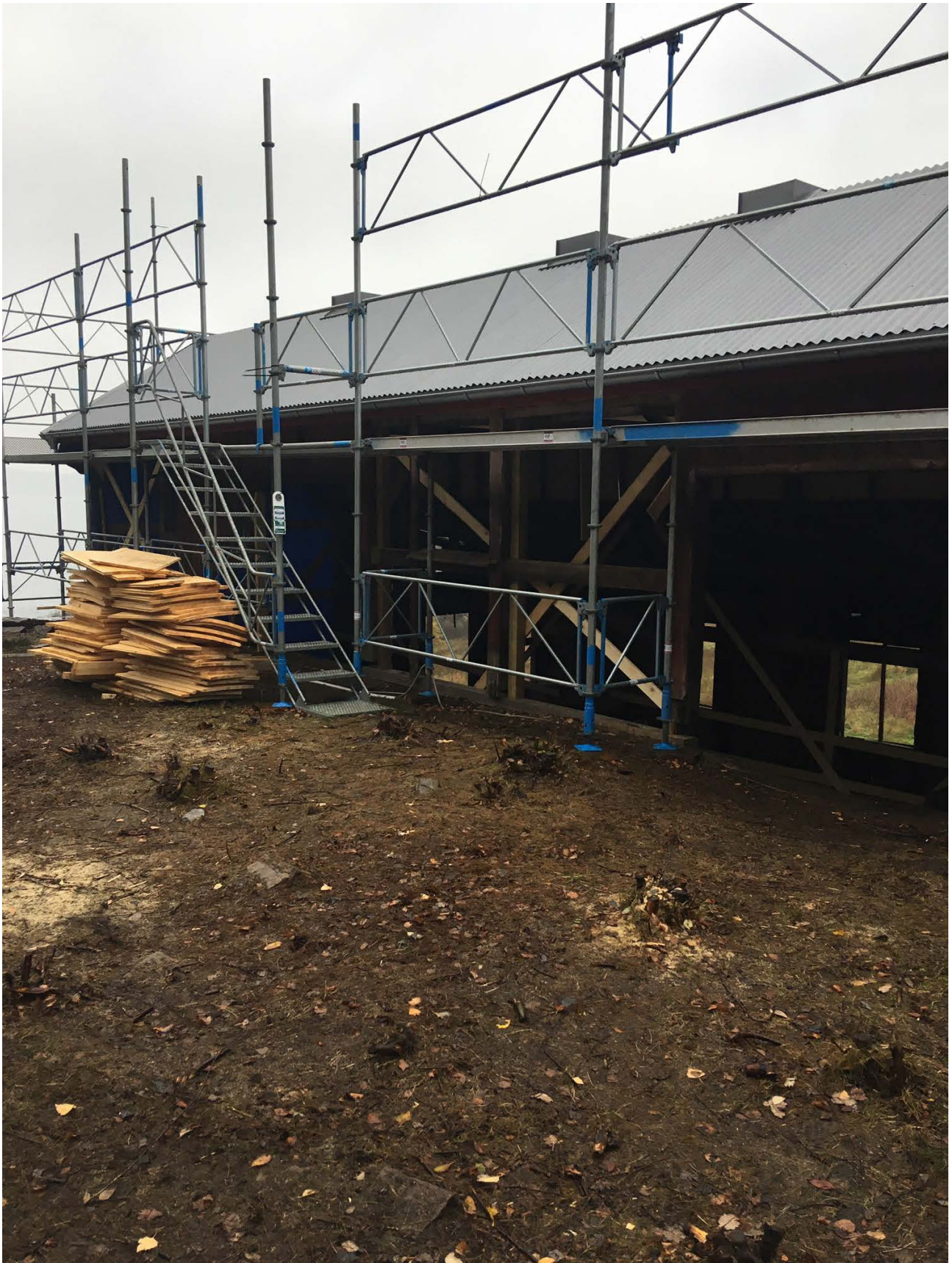
Bild 18. Det nya plåttaket på plats.
