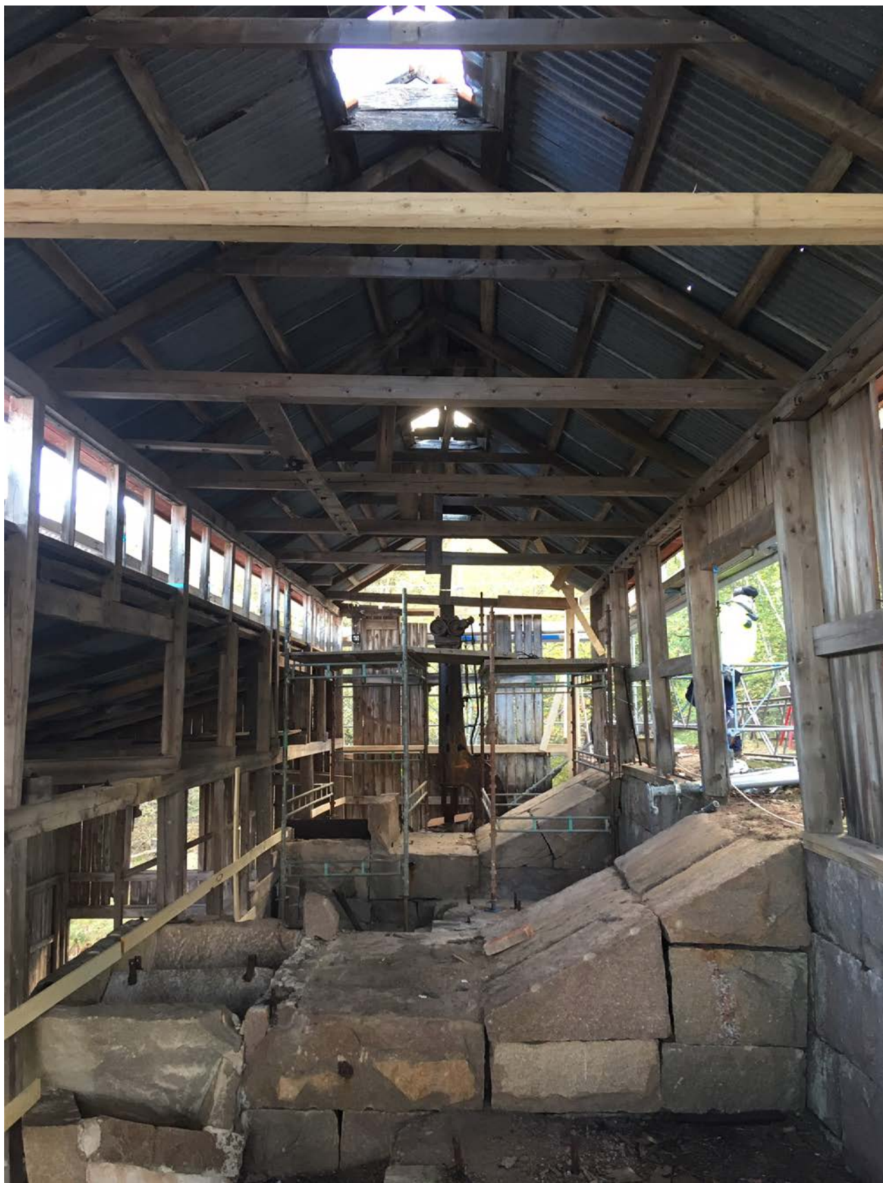
Bild 8. Ställningar monterades kring spaltmaskinen för arbeten med takstolarna.
