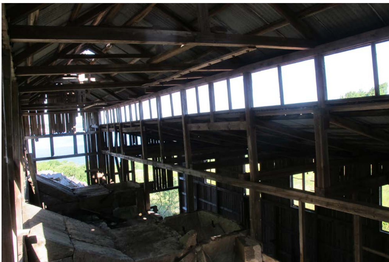
Illustration 2. Interiör med det övre och mellersta planet under sadeltaket. Till höger i bild anas det nedre planet under pulpettak. Tidigare fönsterraden mellan sadeltak och pulpettak syns tydligt.
