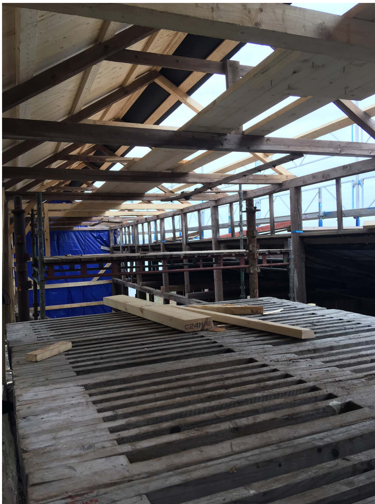
Bild 13. De renoverade takstolarna täcks med råspånt och papp.
