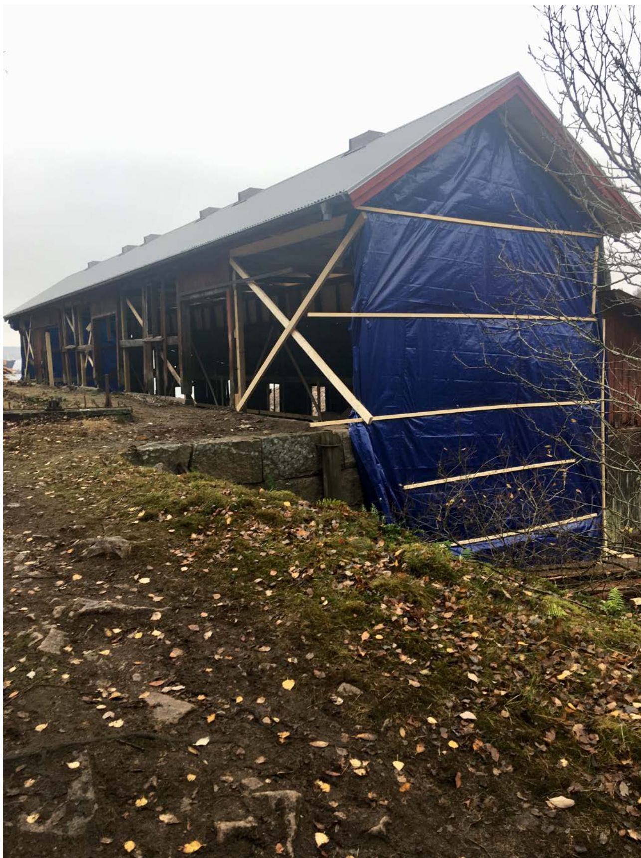
Bild 23. Östra gaveln samt södra långsidan efter arbetet i denna etapp.
