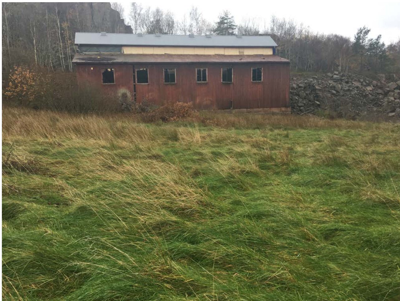
Bild 20. Det färdiga taket och vädersäkring i form av skivor för den tidigare fönsterraden mellan sadeltak och pulpettak.
