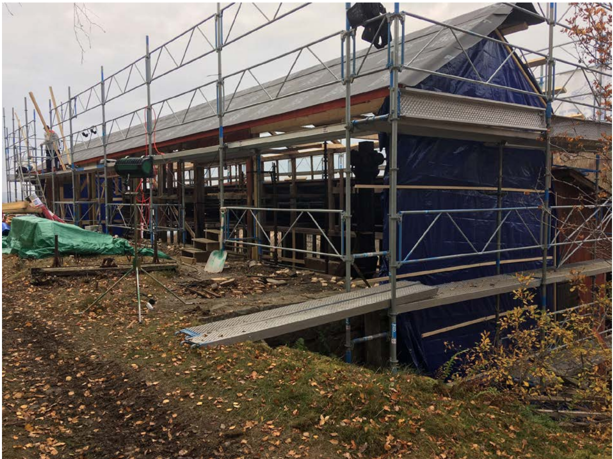
Bild 12. Taket från sydost under arbetets gång.
