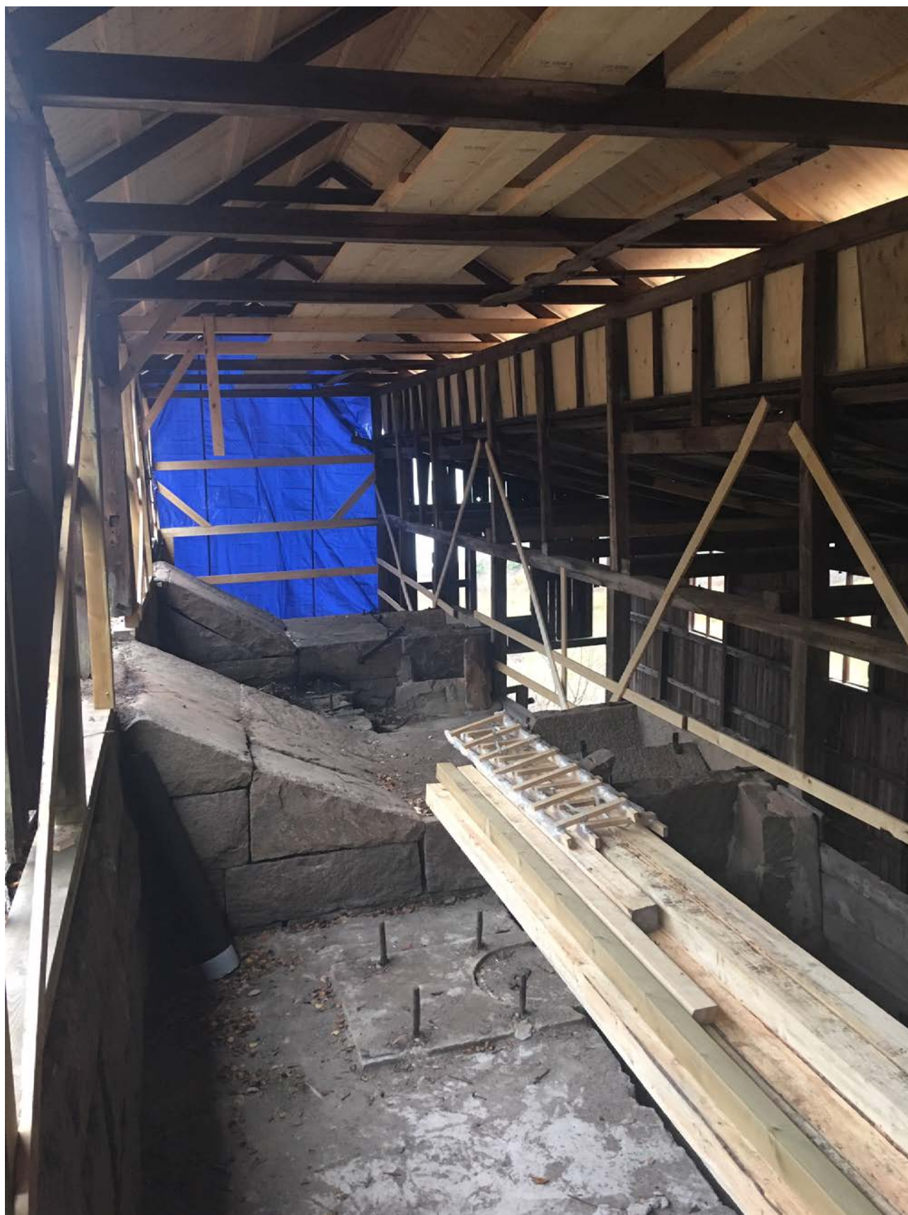
Bild 21. Västra gaveln med vädersäkring och taket från insidan samt tillfälliga snedsträvor och stöd längs långsidorna.
