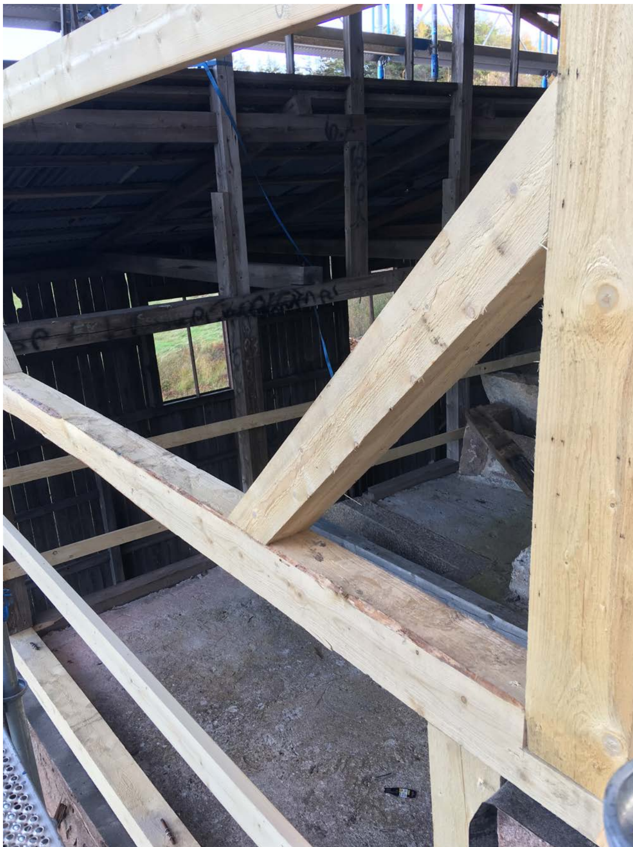
Bild 10. Västra gaveln hade endast lite panel kvar så mycket av stommen var rötskadad och fick bytas ut. Den ersattes med nytt virke i samma dimensioner och sammanfogningar som tidigare.
