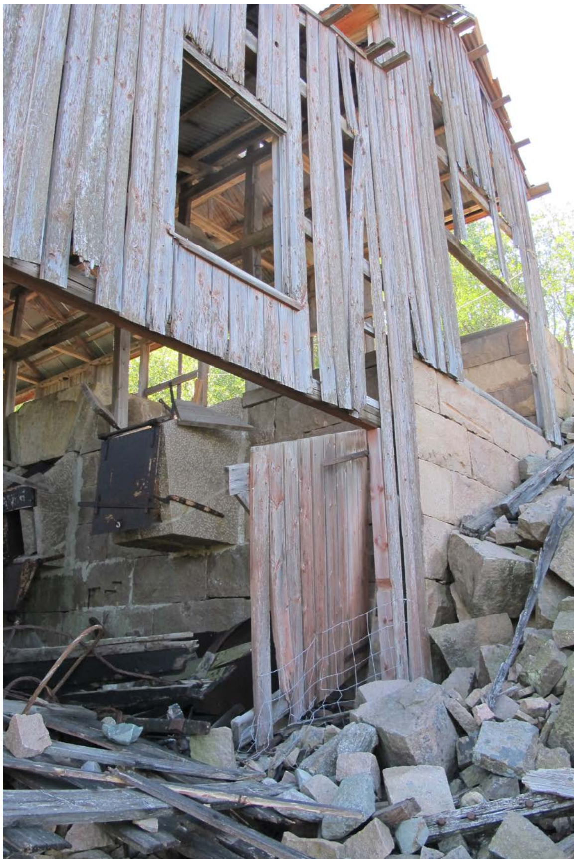
Bild 6. Västra fasaden med den övre delen med sadeltak som prioriterats under denna restaurering. På bilden syns även delar av den nedre delen samt nedkastet med järnlucka där den färdiga gatstenen kom ned.
