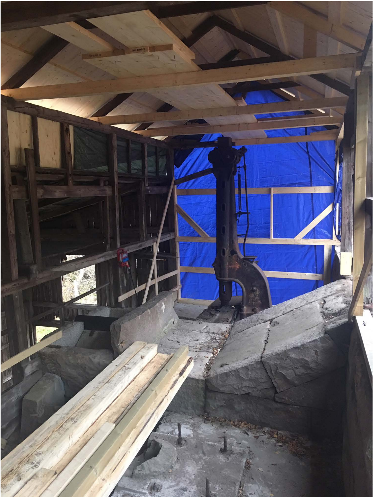
Bild 22. Östra gaveln från insidan. Spaltmaskinen står under tätt tak och väl skyddad.
