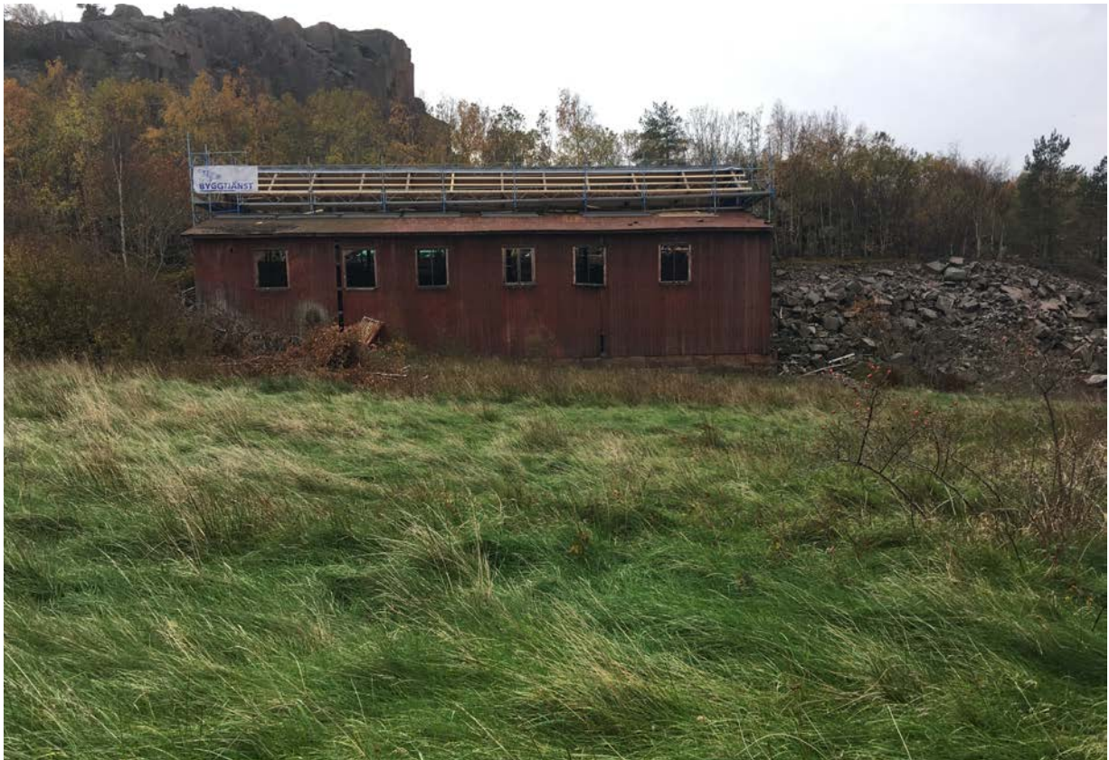
Bild 11. Arbetet med taket påbörjat.
