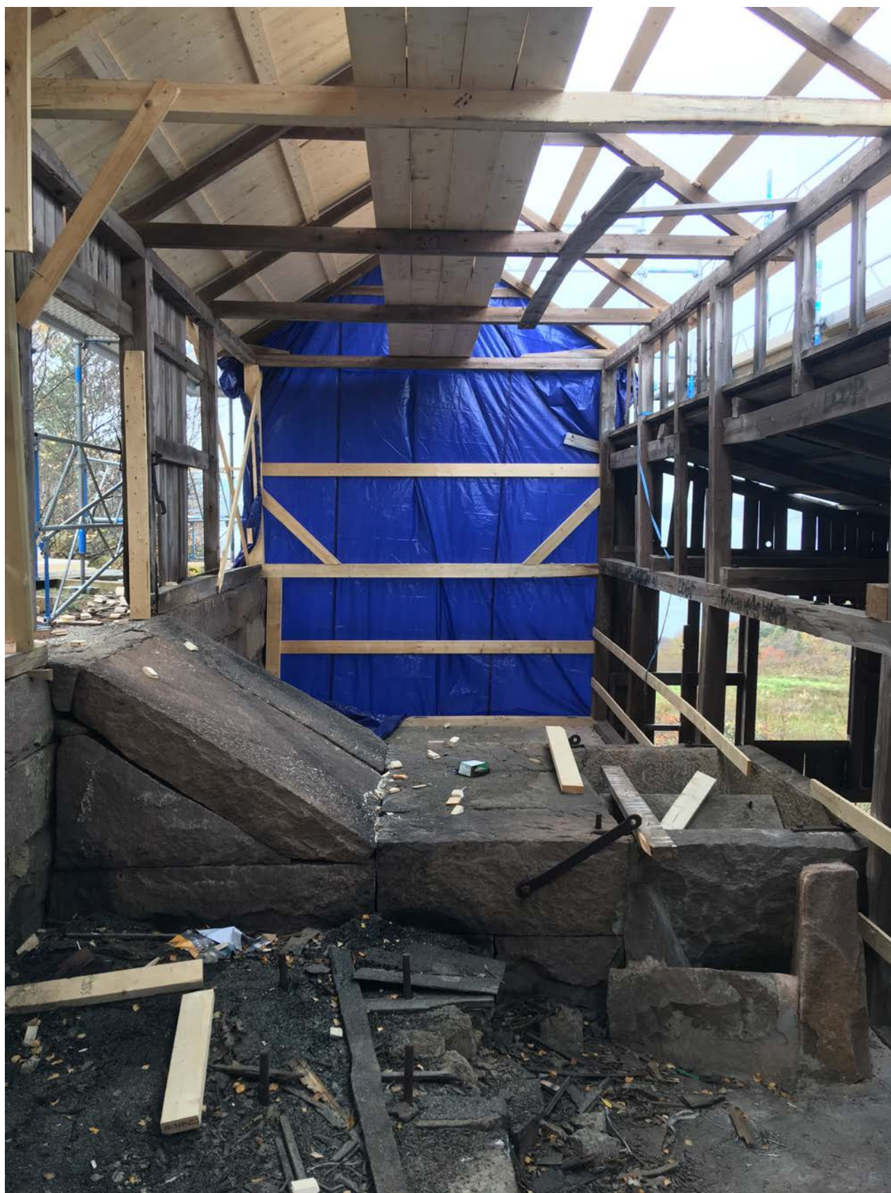
Bild 16. Västra gaveln från insidan. Gaveln har täckts med presenning för att skydda virket i väntan på nästa etapp av restaureringen.
