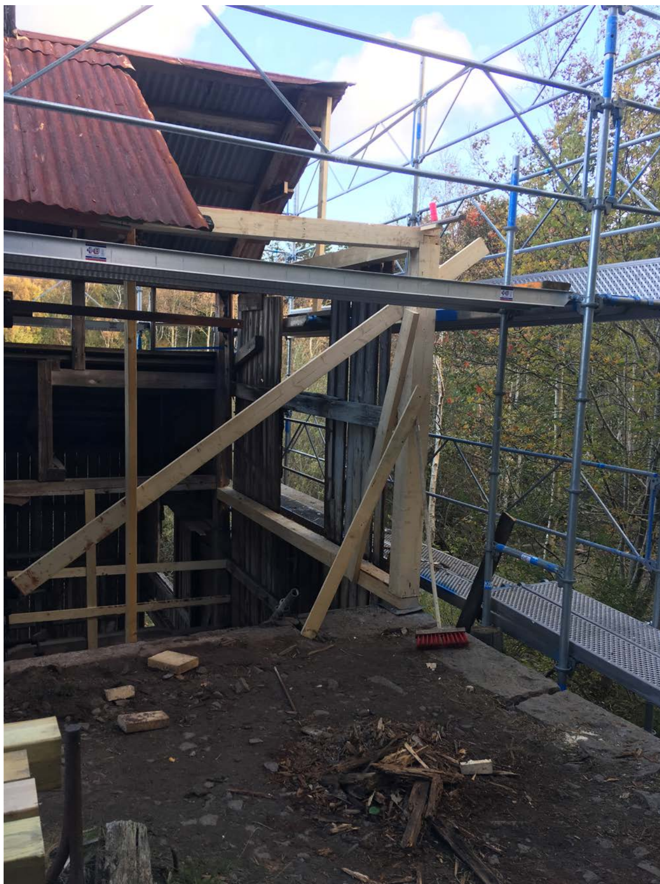
Bild 9. Varsamt byttes rötskadade delar i stommen bit för bit innan arbetet med taket kunde påbörjas.
