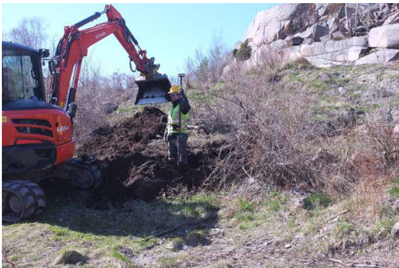
Illustration 33 (överst): Schakt 6 och 9 i sluttningen ovanför bäcken där fynden främst var osvallade. Foto mot öst. Illustration 34 (underst): Schakt 37 togs upp i kanten på schaktmassorna som lagts på Askum 160:1 i den västra delen. Foto mot väst.
