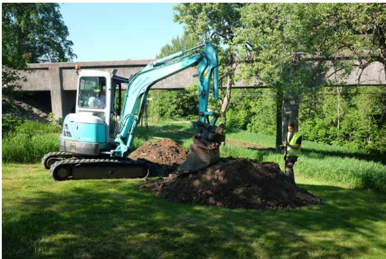
Illustration 8. Schakt 6 på den södra sidan bron. Fredrik mäter in. Foto mot norr.
