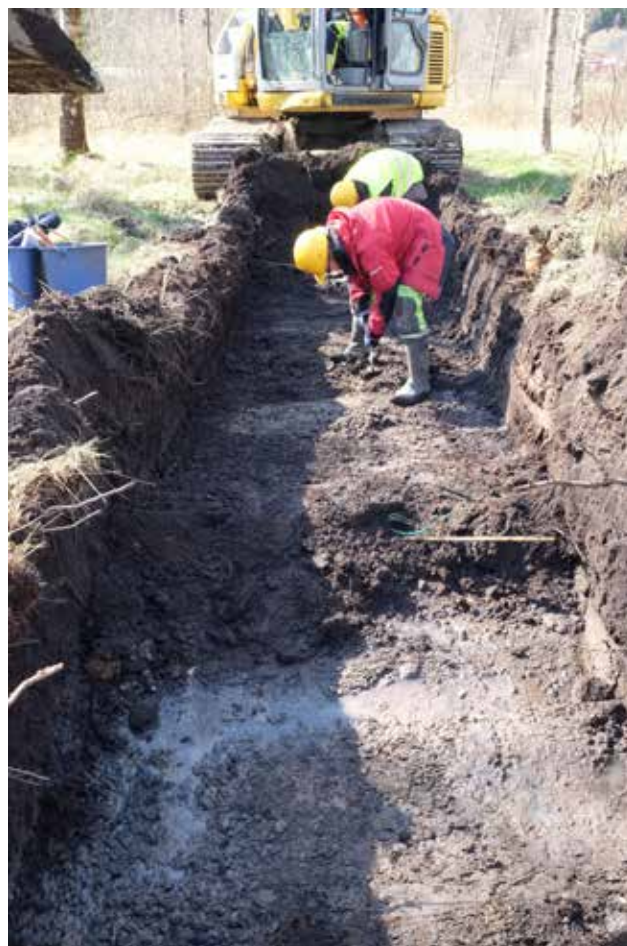
Illustration 5. Stig och Fredrik rensar i schakt 8. Den ljusa fläcken som Stig rensar fram är den ursprungliga gräsbevuxna markytan. Fiberkabeln syns närmare fotografen. Foto mot väster.
