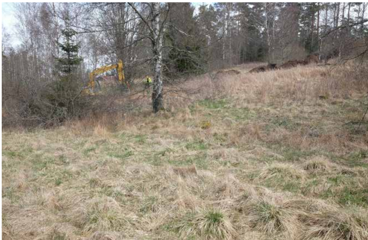
Illustration 8. Del av den södra-centrala delen av utredningsområdet, topografin framgår tydligt. Fotografen står på den äldre vägbanken, schaktning pågår i den norra delen av schakt 1. Foto mot nordost.
