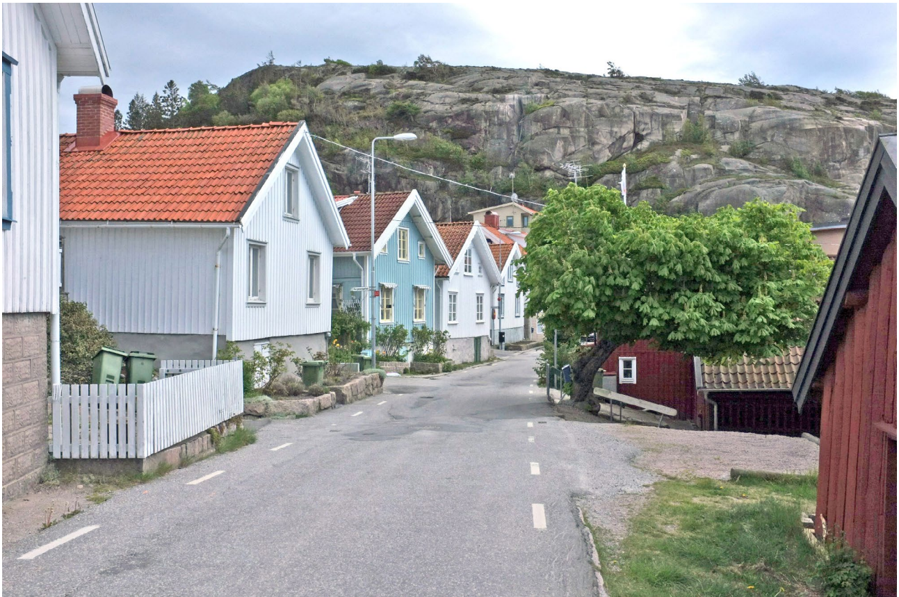
Illustration 2. Äldre traditionella bostadshus utmed Norra hamngatan med gavlarna mot vattnet. Vetteberget i bakgrunden.
