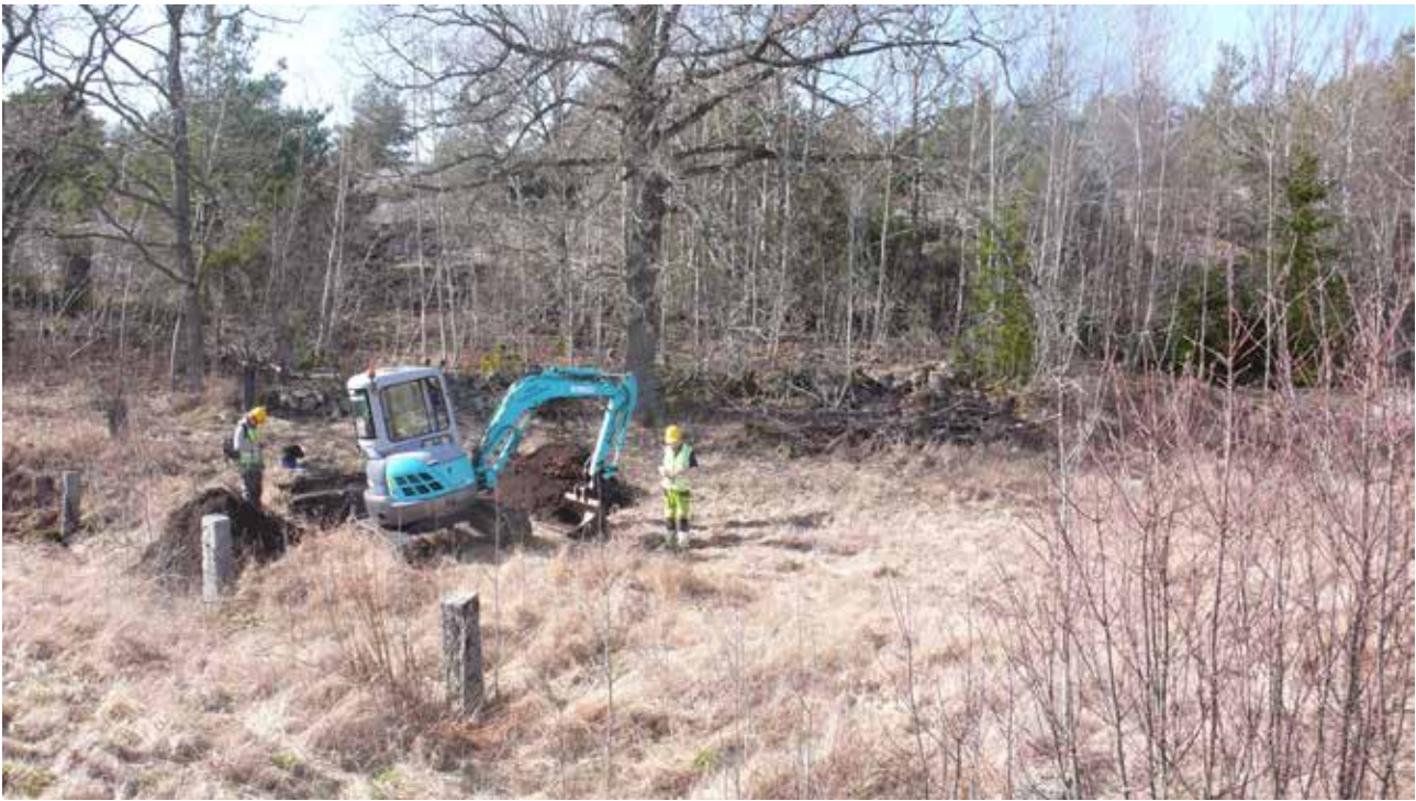
Illustration 3. Schakt 35 upptaget inom odlingsmarken i den södra delen av området. Foto mot väster.
