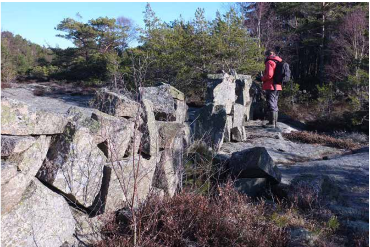
Illustration 41. Stengärdesgård i gränsen mellan Ulmekärr 1:3 och Edsvik 2:1. Muren är konstruerad av skrotsten från stenbrotten inom KUL nr 1701:18.
