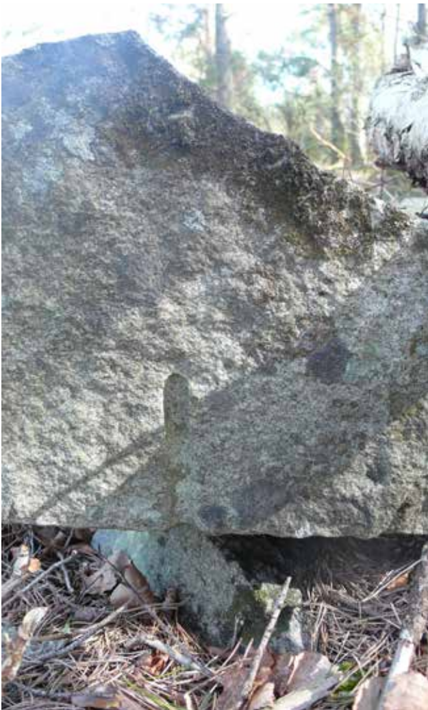
Illustration 44. Märke efter rundkil. Detalj i stenbrott 134 som ingår i småindustriområdet KUL nr 1701:17. Foto mot nordost.
