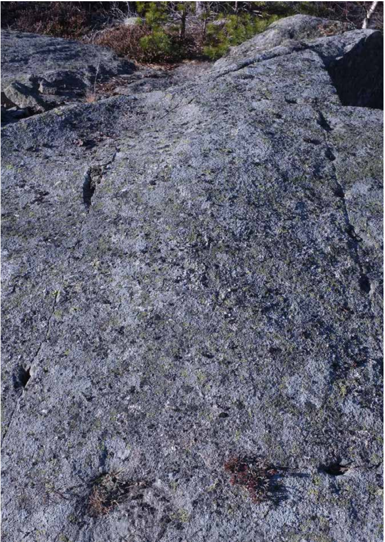
Illustration 12. Detalj från stenbrott nr 121 inom småindustriområde KUL nr 1701:18. På bilden kan ses märken efter rits (till höger) samt breckkil. Foto mot nordväst.
