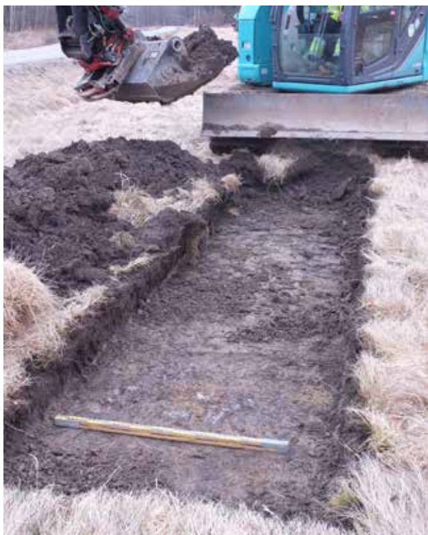
Illustration 27. Läget för anläggning 1 i schakt 24. Foto mot norr.
