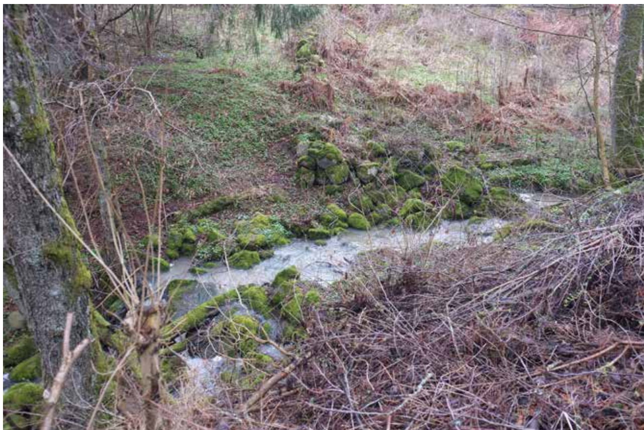
Illustration 16. Troligen ett raserat dämme vid skvaltkvarnen KUL nr 1622:2. Foto mot väster.
