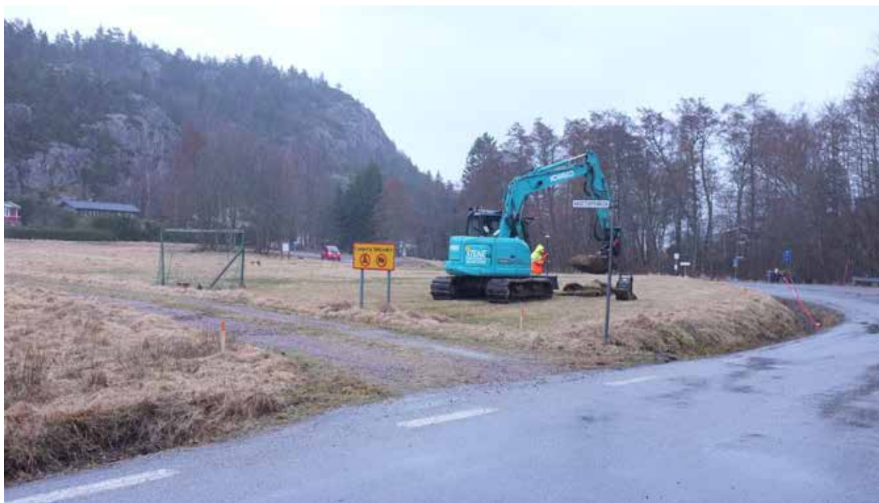
Illustration 11. Bilden visar läget för schakt 28 strax norr om Gårvik. Längre bort på ytan, ungefär vid den stora granen i bildens mitt, är läget för fyndplats för slagen flinta, Foss 47:1. Stig mäter in schaktet. Foto mot söder.
