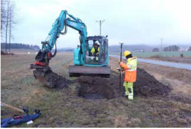
Illustration 7. Stig mäter in schakt 1. Foto mot väster.
