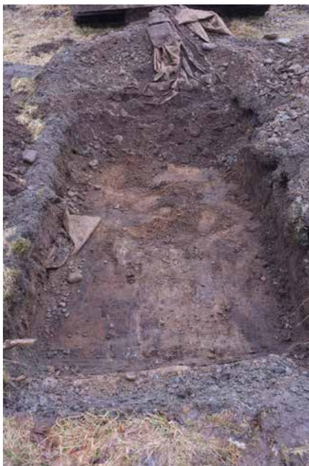
Illustration 25. Schakt 29. Av fotot framgår att de påförda massorna lagts ovanpå markduk. Foto mot norr.
