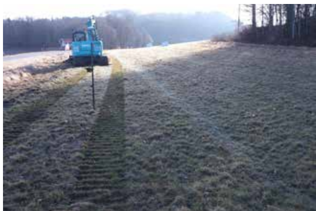
Illustration 4. Till höger i bild anas den höjd där gravfältet Foss 89:1 är beläget. Maskinist Lennart lägger igen schakt 2. Foto mot öster.
