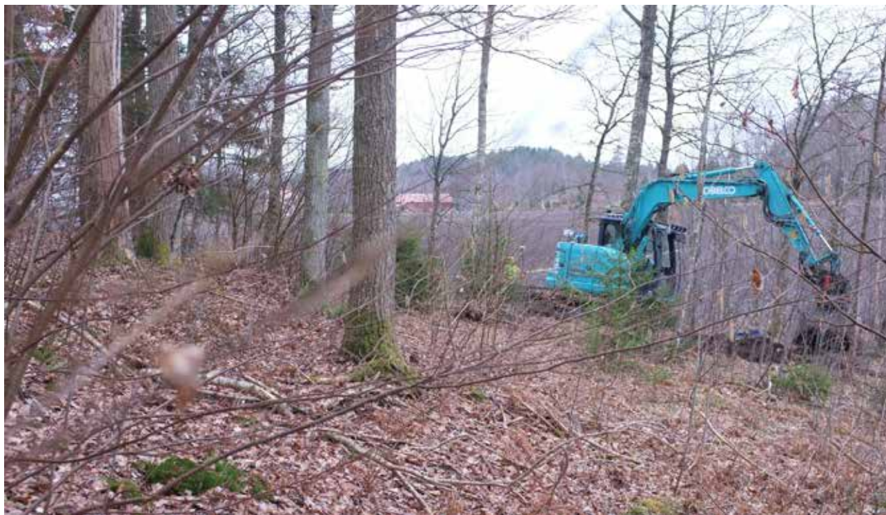
Illustration 18. Läget för boplatsen KUL nr 1622:5. Lennart lägger igen schakt 26. Foto mot sydväst.
