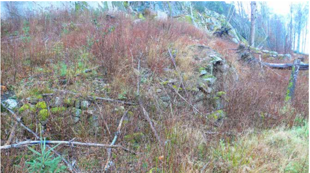
Illustration 10. Rester av jordkällare, eller möjligen en källarvind, inom torplämningen KUL nr 3. Öppningen anas till höger om terrasskanten, och i bakgrunden till höger anas grunden till bostadshuset. Foto mot sydost.
