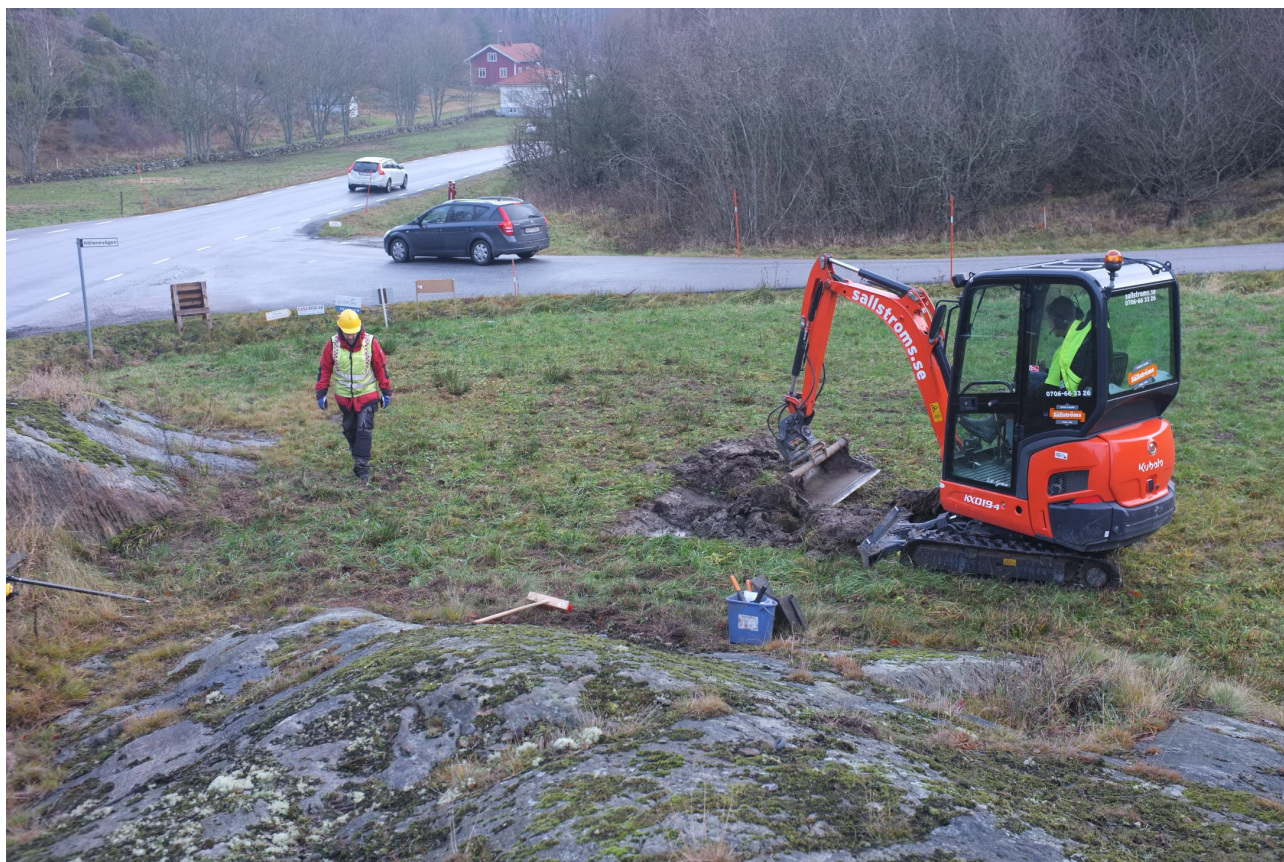
Illustration 1. Grävmaskinisten lägger igen schakt 4. Klövedal 11 på andra sidan vägen - skylten sticker upp bakom den mörka bilen. Foto mot öster.
