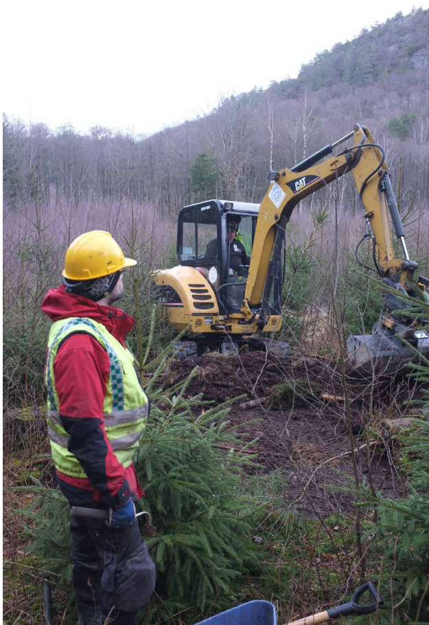
Illustration 6. Grävmaskinist Mikael har just påbörjat schakt 2, Andreas tittar på. Del av Aleklätten i bakgrunden. Foto mot nordost.
