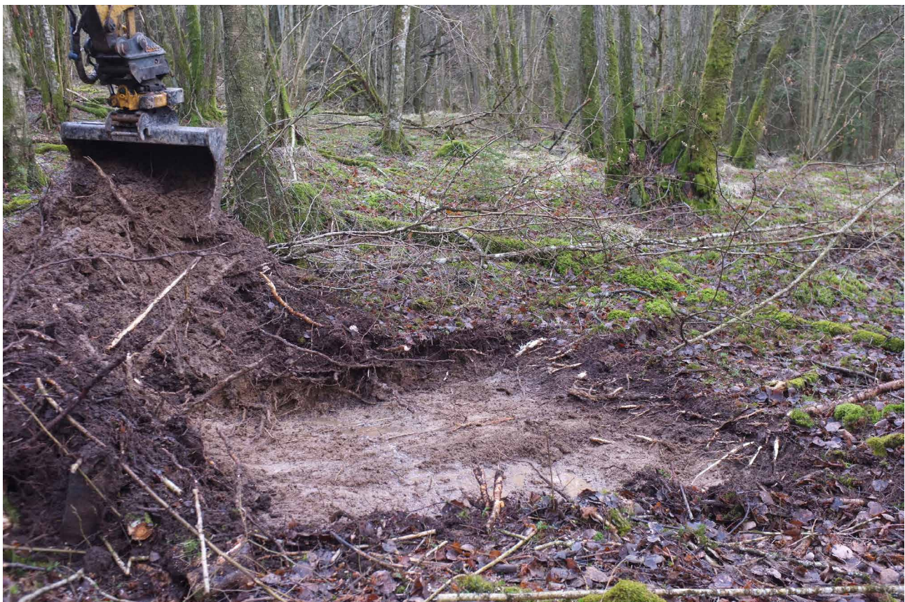
Illustration 24. Schakt 15, upptaget i områdets södra del på en av avsatserna mellan berget och sumpskogen. Foto mot söder.
