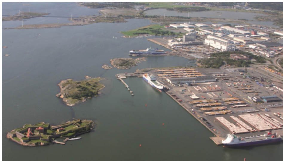
Illustration 6. Göteborgs hamn, Aspholmarna och Älvsborgs fästning. Den beslutade utbyggnaden av hamnen leder till att Lilla Aspholmen, den mindre holmen intill fartyget på bilden, sprängs bort och att kajerna byggs ut utanför fästningsholmen.
