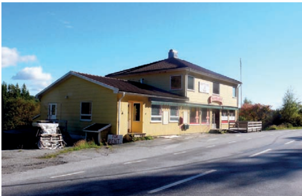
Illustration 23. Den före detta affären i Vassbotten som ända fram tills nyligen varit igång.
