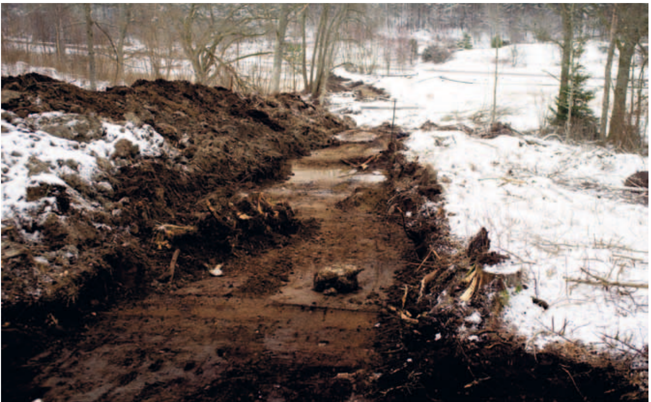
Illustration 13. Översikt över del av schakt 5. I bakgrunden syn delar av schakt 4, foto mot nordost.
