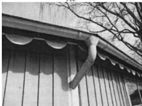
Plåtbeck i original
