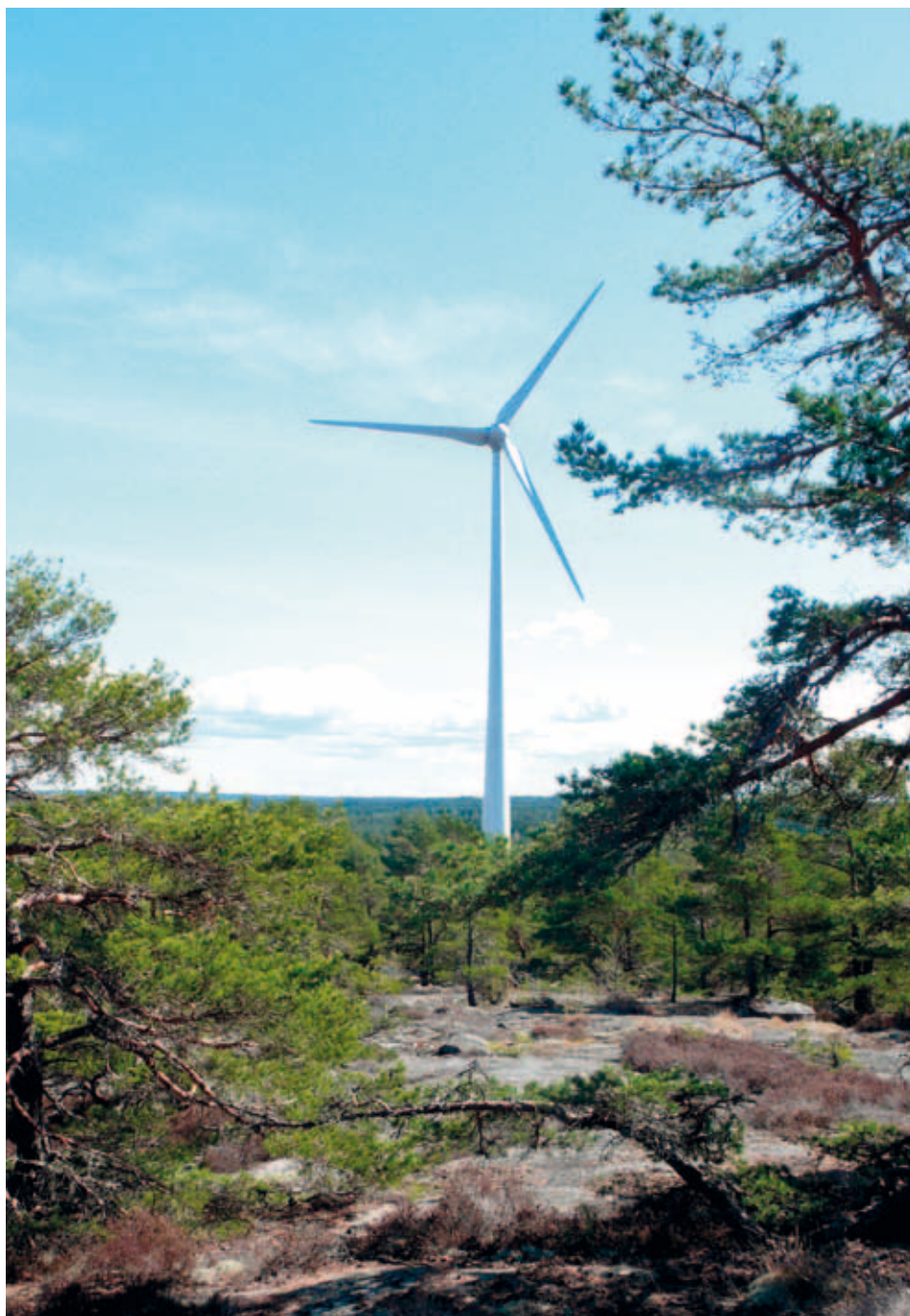
Figur 2. Vindkraftverken har idag blivit betydligt större än de som byggdes under 1990-talet. Det här vindkraftverket vid Kil i norra Tanums kommun har en totalhöjd på nästan 150 meter och en effekt på 2 MW.
