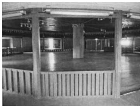
Invändiga stolpar i original
