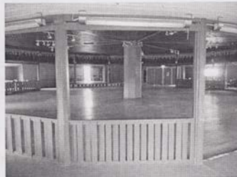
Invändiga stolpar i original
