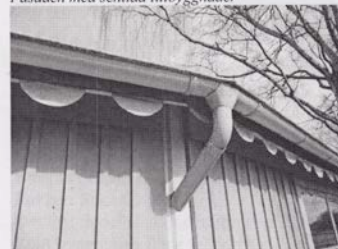
Plåtbeck i original
