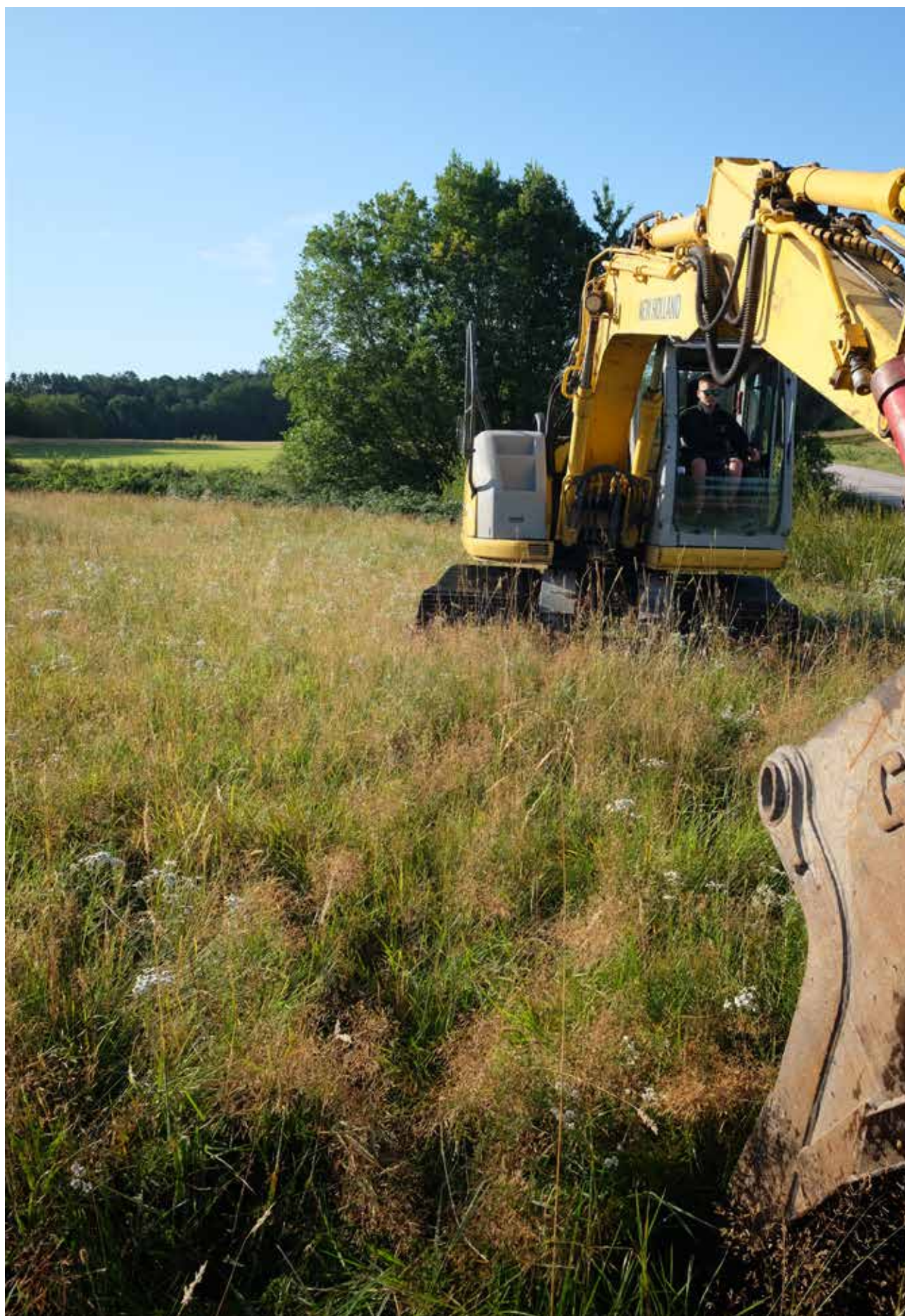
Illustration 7. Norra ytan med vall. Landsvägen skymtar till höger bakom maskinen. Foto mot sydost.
