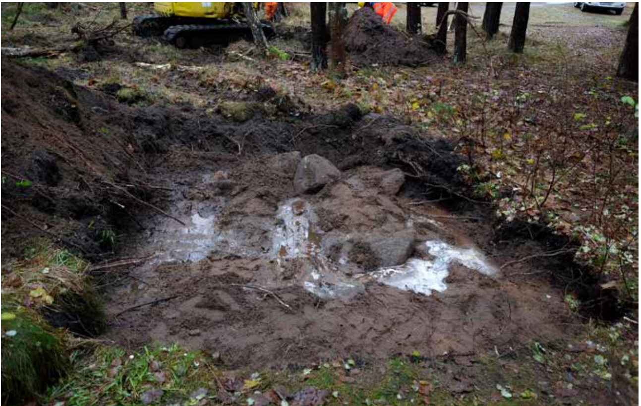
Illustration 4. Schakt 3 fylls snabbt med vatten medan grävmaskinen fyller igen schakt 1 och 2. Foto mot syd.
